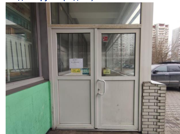
Входная группа (подвал)
