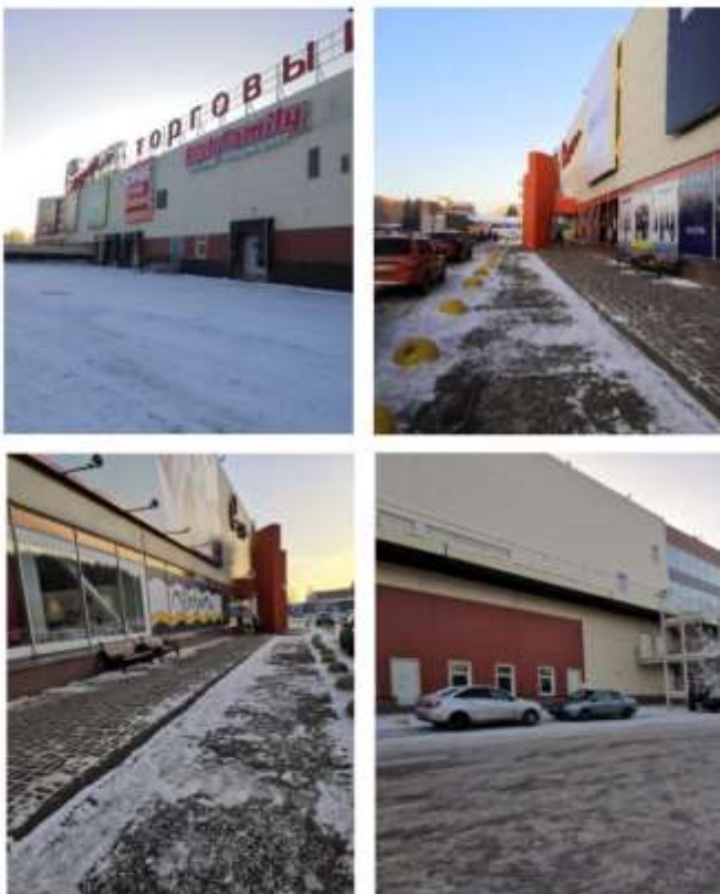
Общий вид нежилого здания, прилегающая территория.
