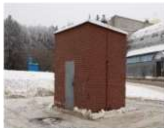
Здание КНС отдельного стояка
