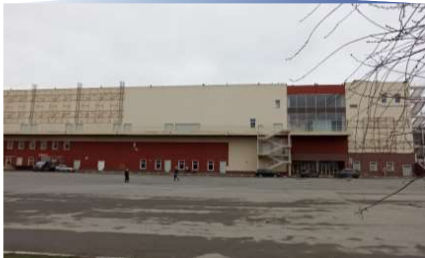
Источники: Данные визуального осмотра
