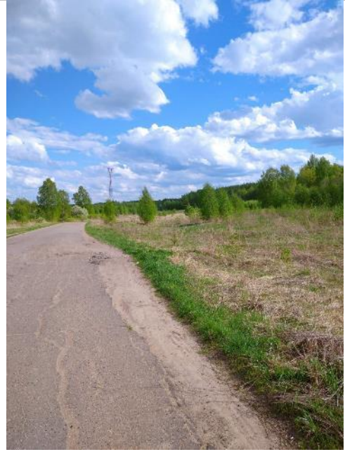
Фото 36. Прилегающая территория и подъездные пути.
