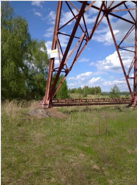
Фото 29. Прилегающая территория и подъездные пути.
