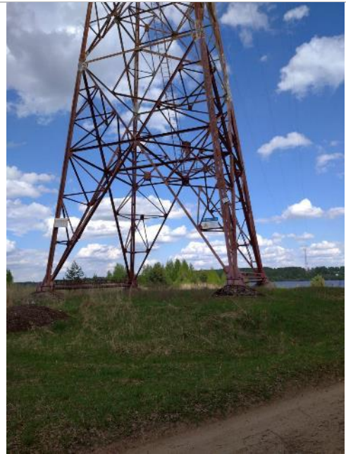
Фото 38. Прилегающая территория и подъездные пути.
