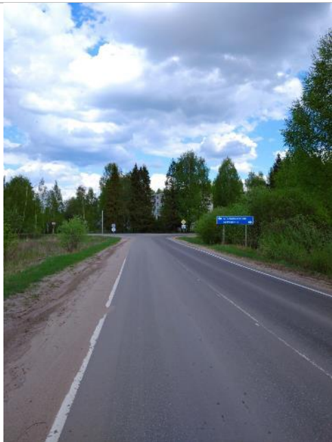
Фото 23. Прилегающая территория и подъездные пути.
