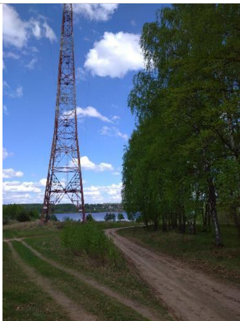
Фото 41. Прилегающая территория и подъездные пути.
