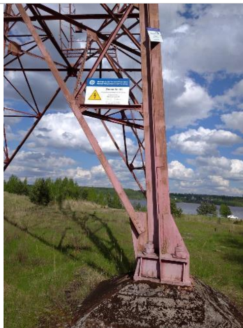
Фото 40. Прилегающая территория и подъездные пути.
