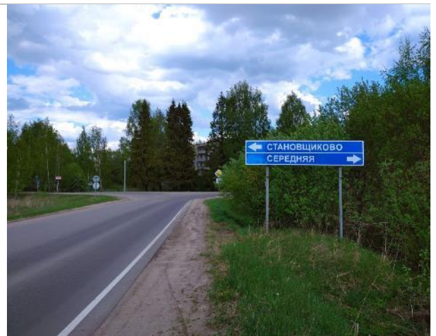
Фото 22. Прилегающая территория и подъездные пути.
