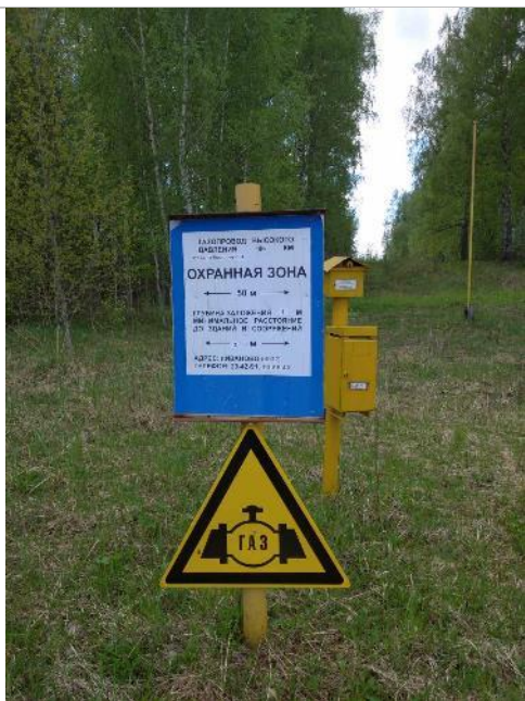
Фото 31. Прилегающая территория и подъездные пути.
