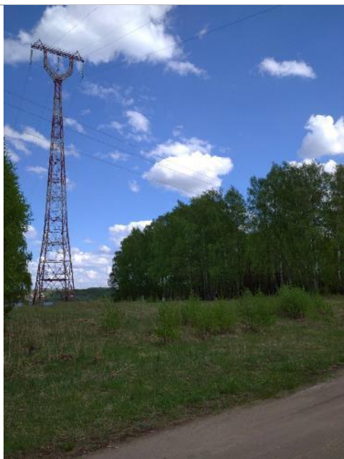
Фото 25. Прилегающая территория и подъездные пути.
