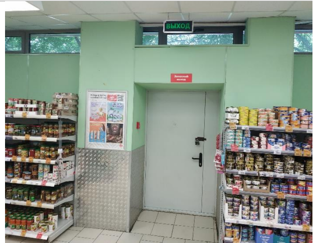
Фото 20. Фрагменты внутренних помещений
