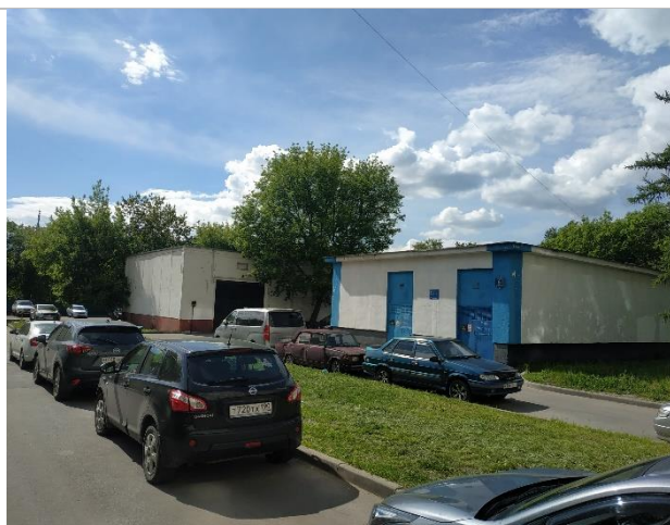
Фото 3. Прилегающая территория и подъездные пути
