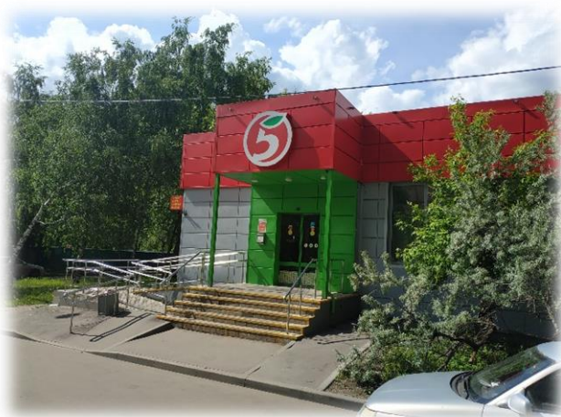
Фотография 3.3. Прилегающая территория, фасад здания
