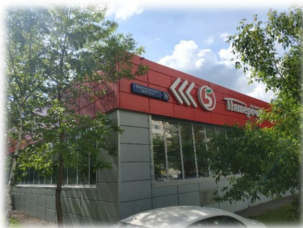
Фотография 3.4. Прилегающая территория, фасад здания
