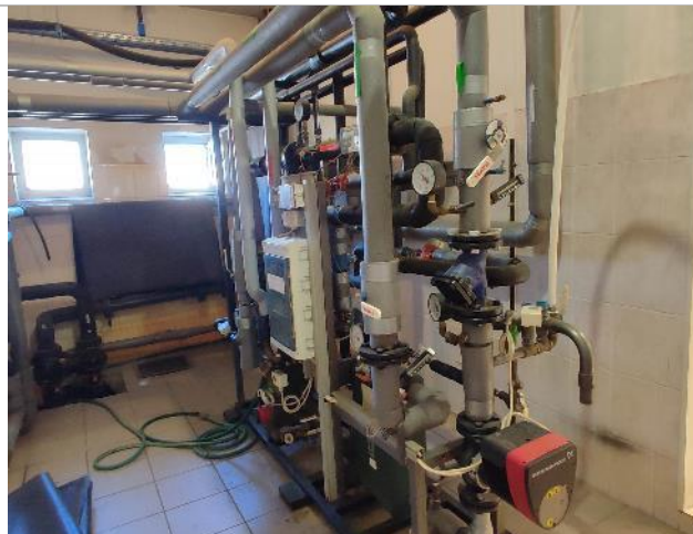
Фотография 3.8. Состояние внутренних помещений
