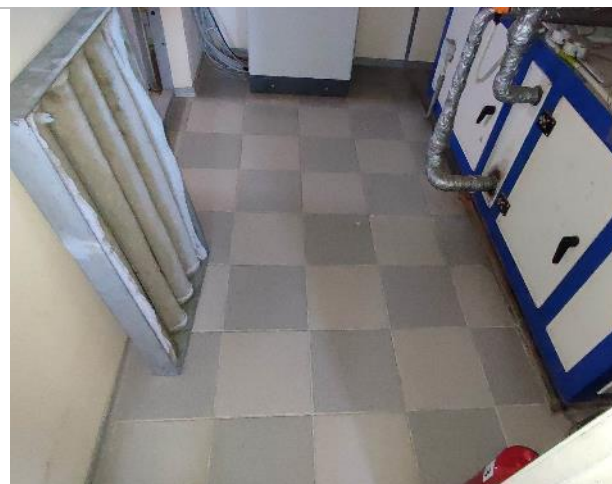
Фотография 113. 2 этаж. (внутренние помещения)
