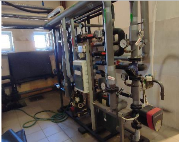
Фотография 19. 1 этаж. (внутренние помещения)
