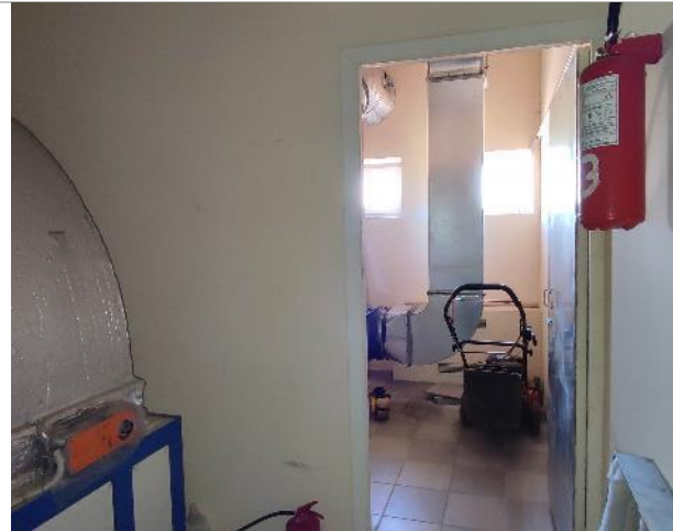
Фотография 109. 2 этаж. (внутренние помещения)
