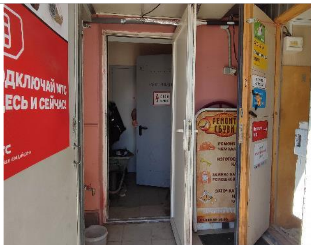
Фотография 36. 1 этаж. электрощитовая вход с улицы. (внутренние помещения)
