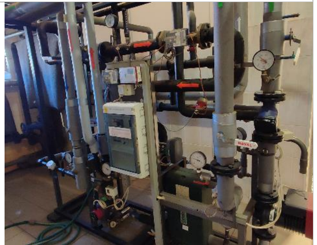
Фотография 16. 1 этаж. (внутренние помещения)
