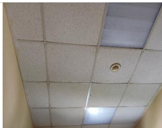
Фотография 95. 2 этаж. (внутренние помещения)
