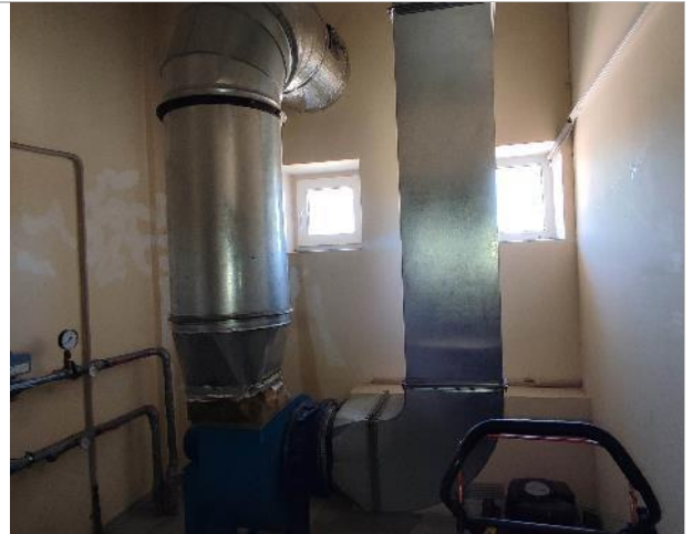
Фотография 110. 2 этаж. (внутренние помещения)
