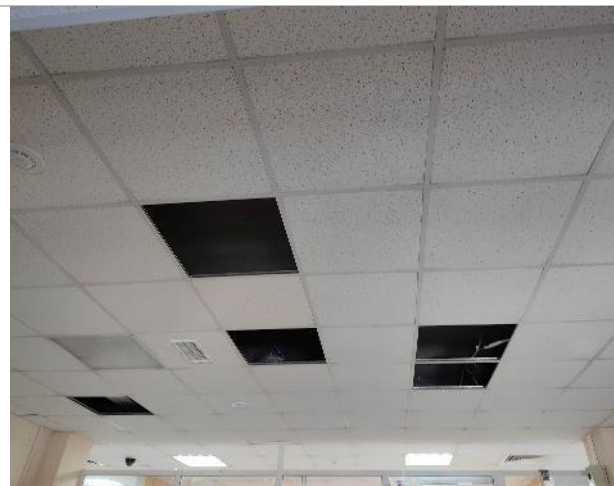
Фотография 63. 2 этаж. (внутренние помещения)
