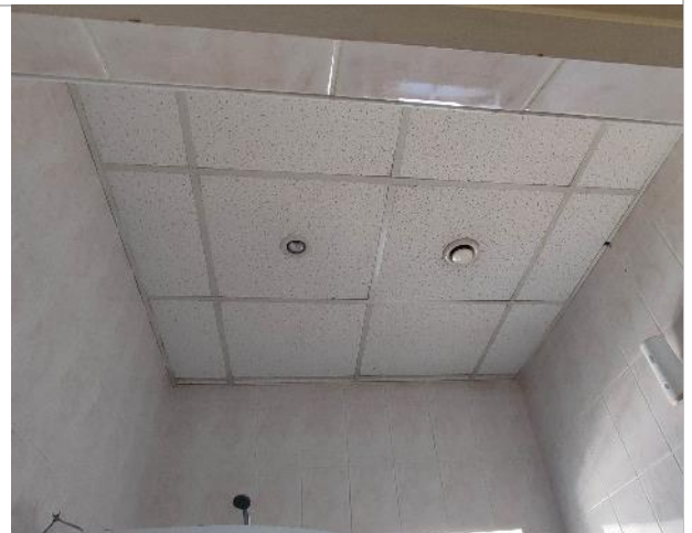
Фотография 90. 2 этаж. (внутренние помещения)
