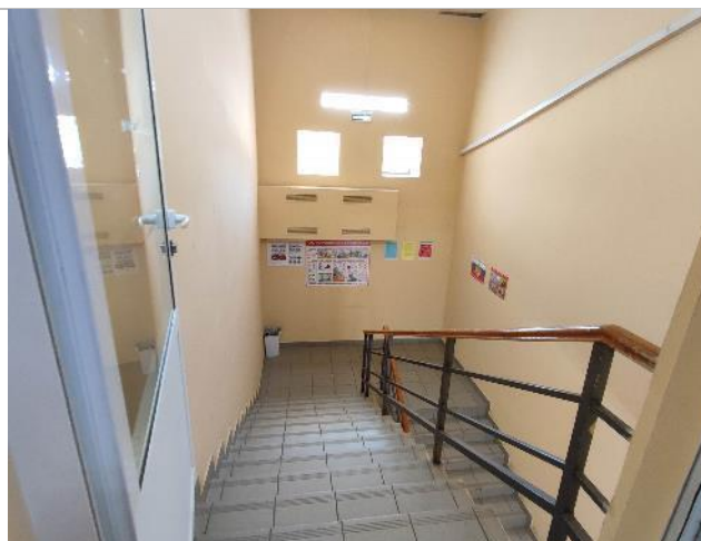
Фотография 3.11. Состояние внутренних помещений
