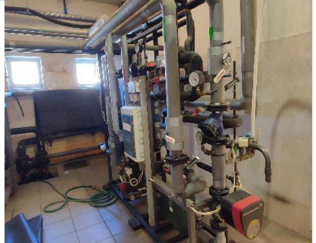
Фотография 14. 1 этаж. (внутренние помещения)
