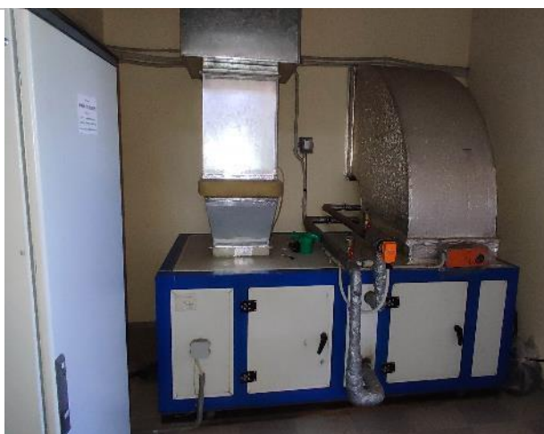
Фотография 108. 2 этаж. (внутренние помещения)
