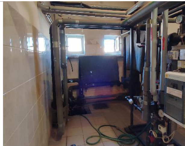
Фотография 17. 1 этаж. (внутренние помещения)
