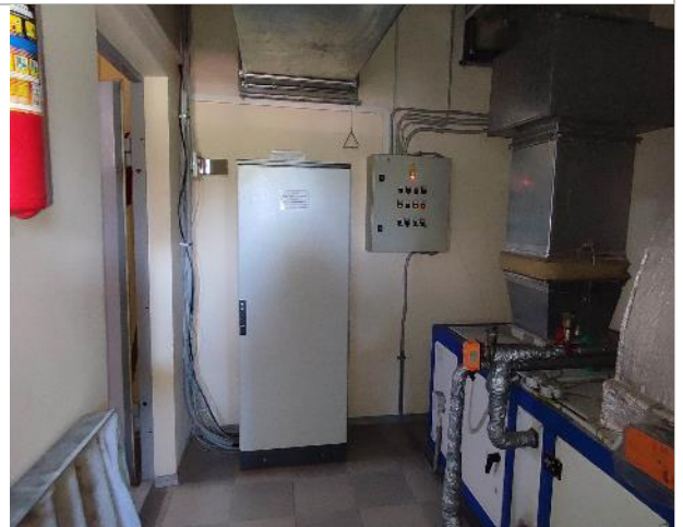
Фотография 112. 2 этаж. (внутренние помещения)
