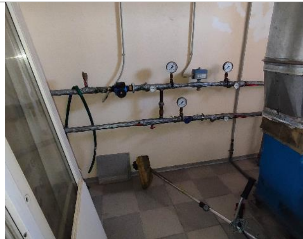
Фотография 111. 2 этаж. (внутренние помещения)
