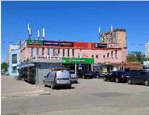
Фотография 3.3. Прилегающая территория, фасад здания
