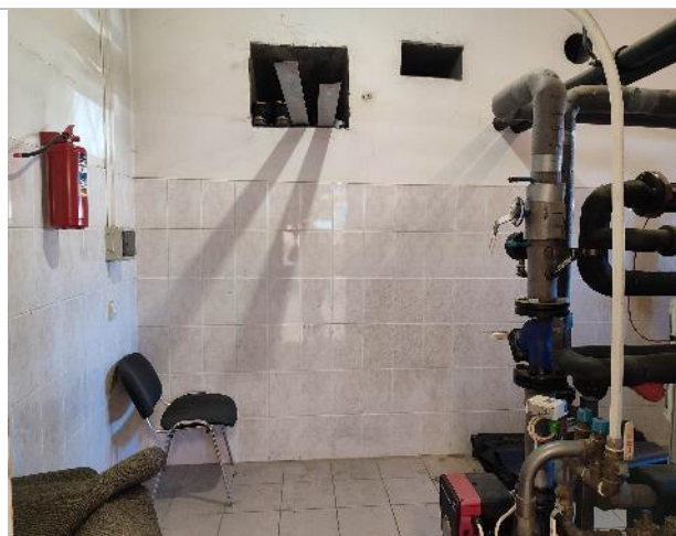
Фотография 12. 1 этаж. (внутренние помещения)
