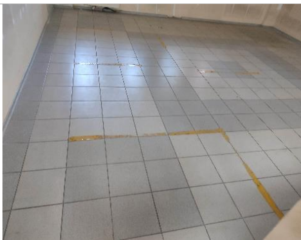
Фотография 60. 2 этаж. (внутренние помещения)
