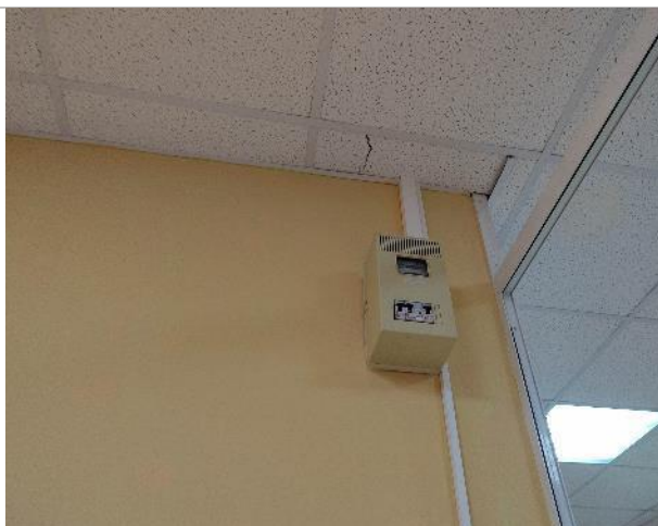
Фотография 68. 2 этаж. (внутренние помещения)
