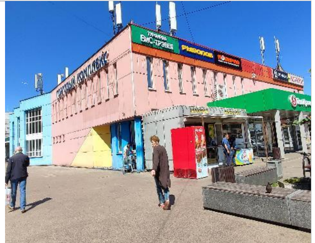
Фотография 122. Фасад здания, парковка
