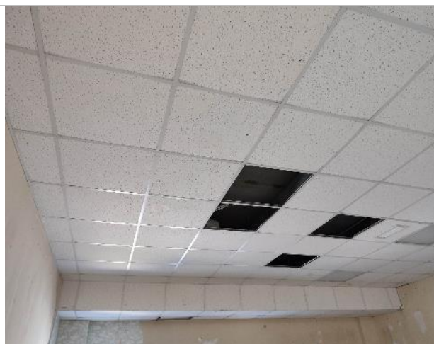
Фотография 59. 2 этаж. (внутренние помещения)
