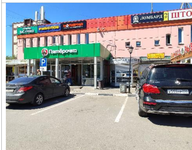
Фотография 141. Фасад здания, парковка
