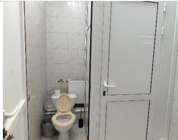
Фотография 87. 2 этаж. (внутренние помещения)
