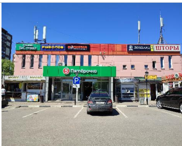
Фотография 142. Фасад здания, парковка
