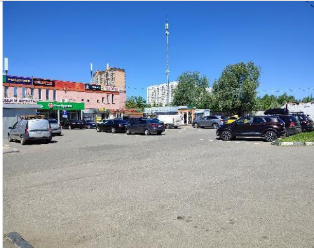
Фотография 116. Фасад здания, парковка
