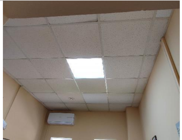
Фотография 98. 2 этаж. (внутренние помещения)
