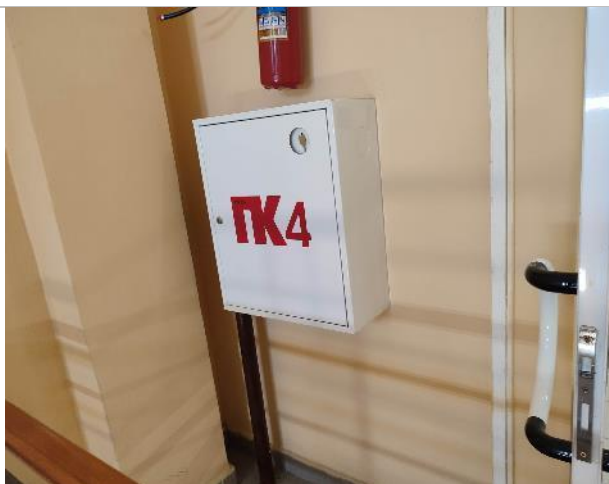
Фотография 44. 2 этаж. (внутренние помещения)
