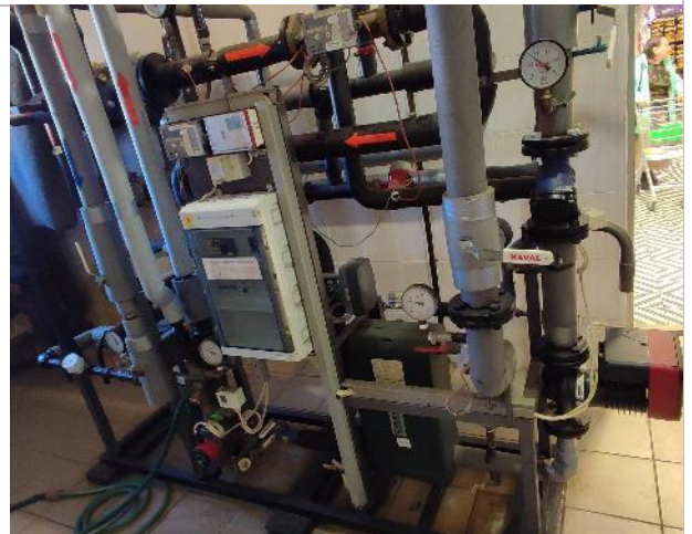
Фотография 18. 1 этаж. (внутренние помещения)
