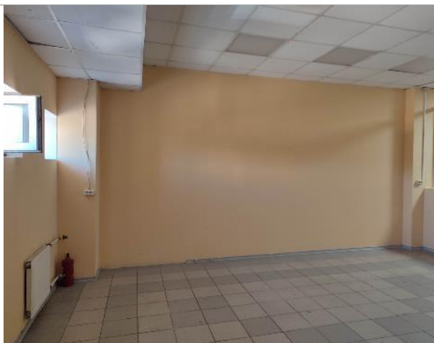
Фотография 56. 2 этаж. (внутренние помещения)
