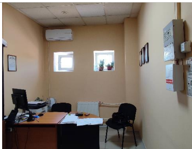
Фотография 3.12. Состояние внутренних помещений
