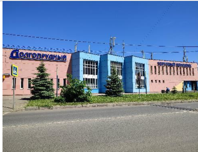
Фотография 3.4. Прилегающая территория, фасад здания
