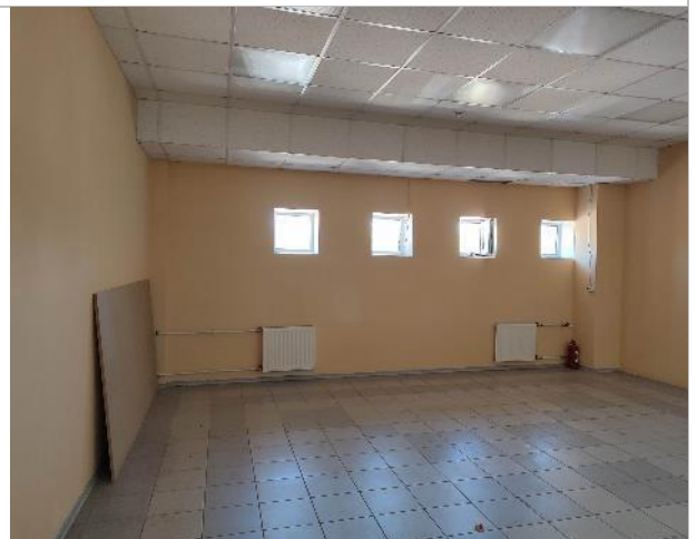
Фотография 54. 2 этаж. (внутренние помещения)
