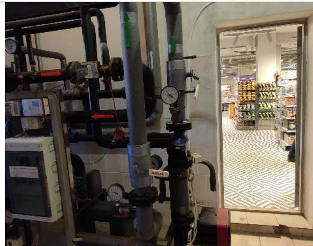
Фотография 15. 1 этаж. (внутренние помещения)
