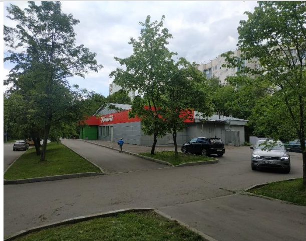
Фото 1. Внешний вид здания
