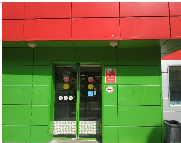
Фото 5. Внешний вид здания
