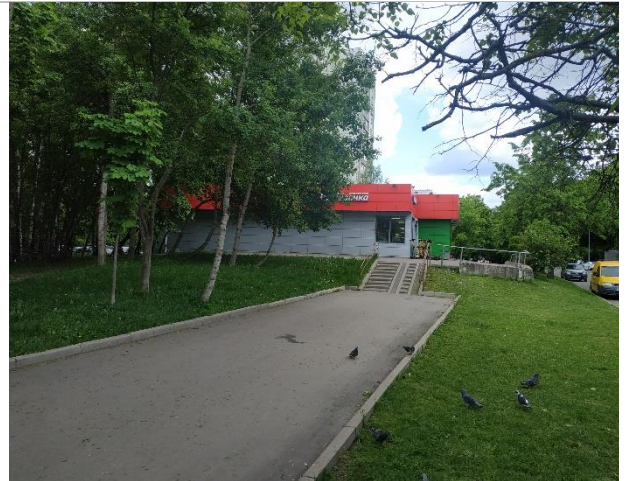
Фото 2. Внешний вид здания
