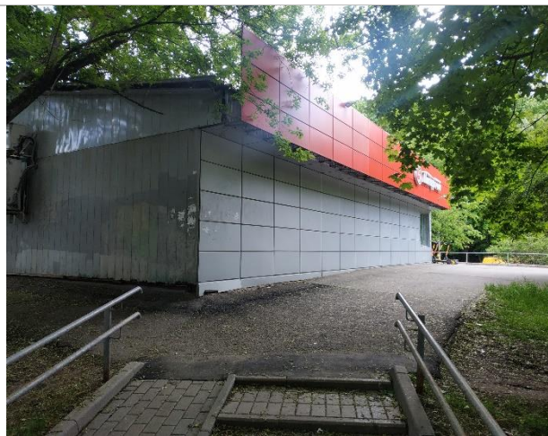
Фото 3. Внешний вид здания
