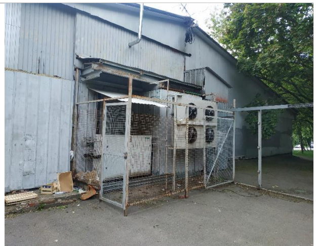
Фото 4. Внешний вид здания
