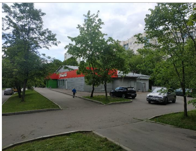
Фотография 3.3. Прилегающая территория, фасад здания
