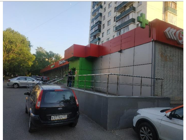
Фотография 3.4. Прилегающая территория, фасад здания
