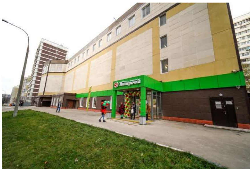
Фото 1. Внешний вид здания, вход в оцениваемые помещения
