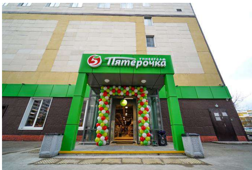
Фото 2. Внешний вид здания, вход в оцениваемые помещения
