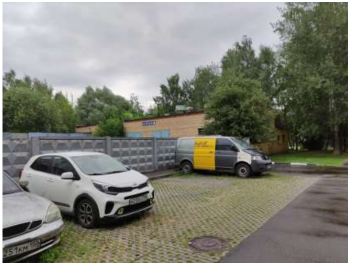
Общий вид здания котельной
