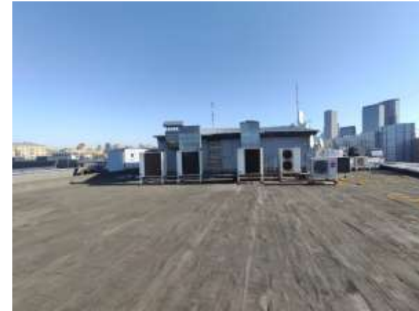
Кровля и техническое помещение (венткамера)
