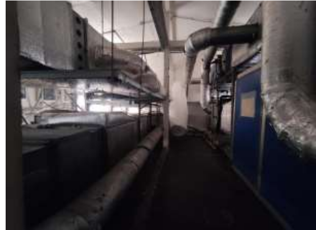
Кровля и техническое помещение (венткамера)
