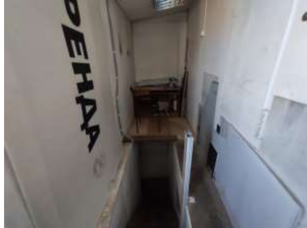
Кровля и техническое помещение (венткамера)
