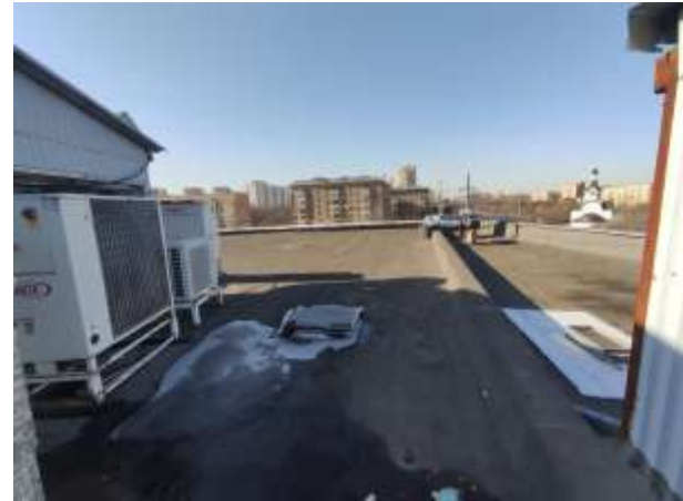
Кровля и техническое помещение (венткамера)
