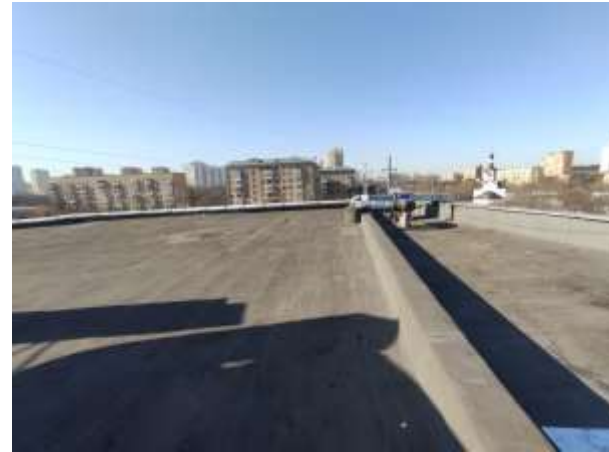
Кровля и техническое помещение (венткамера)
