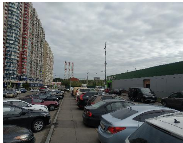
Фото 31. Фасад оцениваемого нежилого здания.
