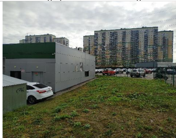
Фото 35. Фасад оцениваемого нежилого здания.
