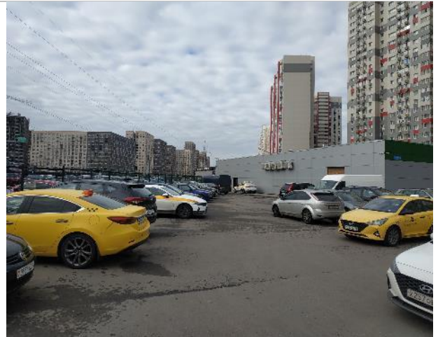
Фото 38. Фасад оцениваемого нежилого здания.
