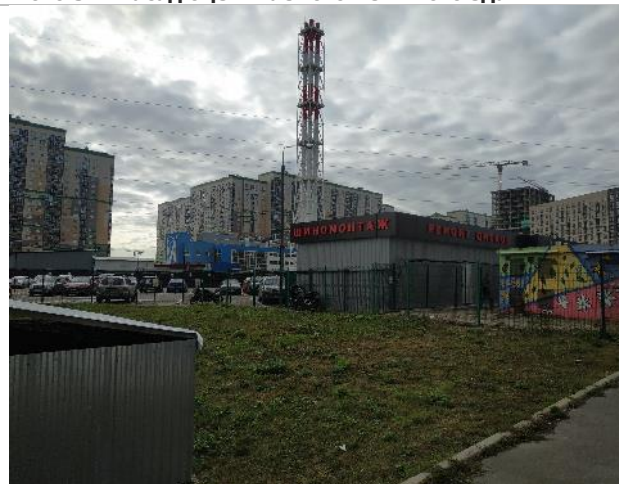
Фото 33. Фасад оцениваемого нежилого здания.
