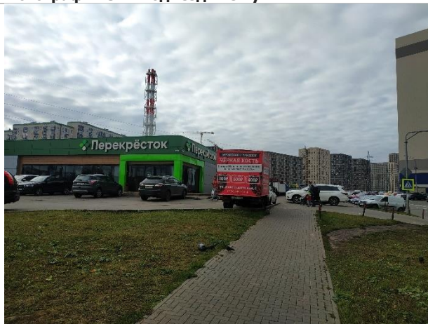
Фотография 3.3. Прилегающая территория, фасад здания
