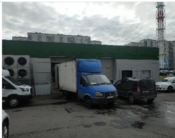
Фото 32. Фасад оцениваемого нежилого здания.
