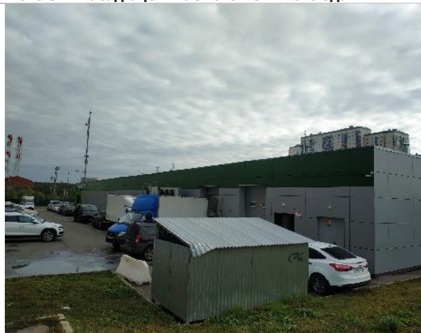
Фото 34. Фасад оцениваемого нежилого здания.
