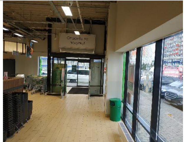
Фото 26. Помещения оцениваемого нежилого здания.
