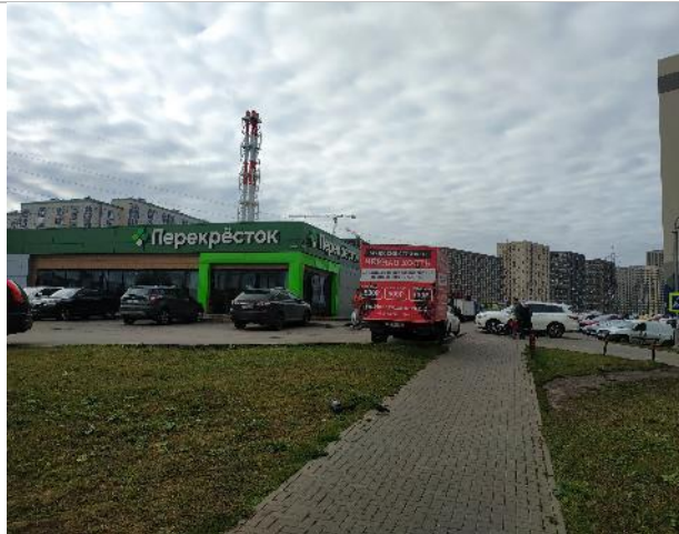
Фото 37. Фасад оцениваемого нежилого здания.
