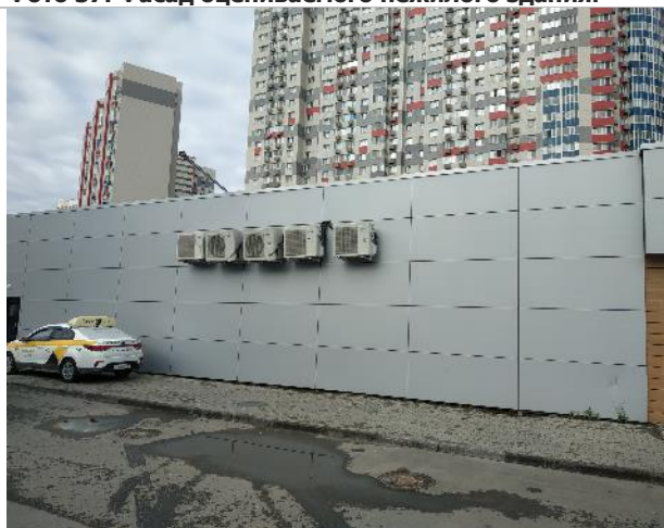
Фото 39. Фасад оцениваемого нежилого здания.
