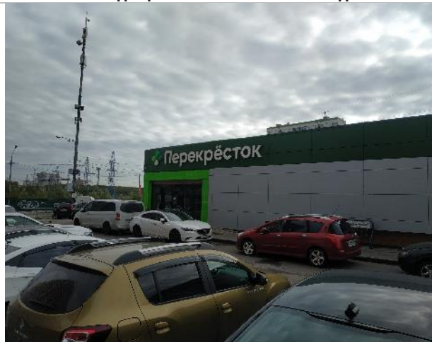
Фото 36. Фасад оцениваемого нежилого здания.
