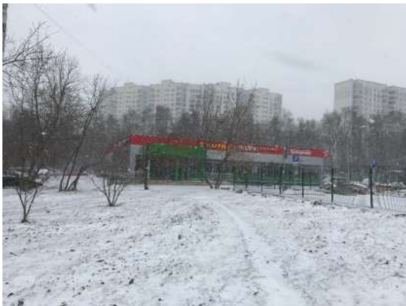
Фото 1. Внешний вид здания
