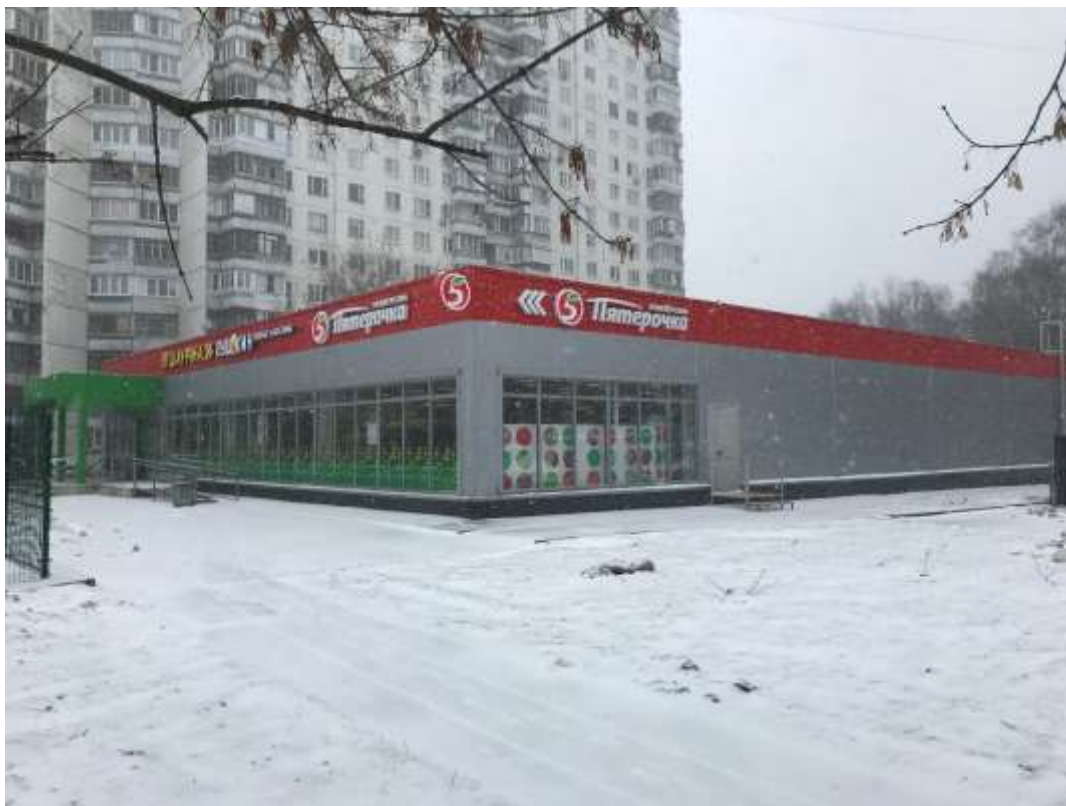
Фото 4. Внешний вид здания
