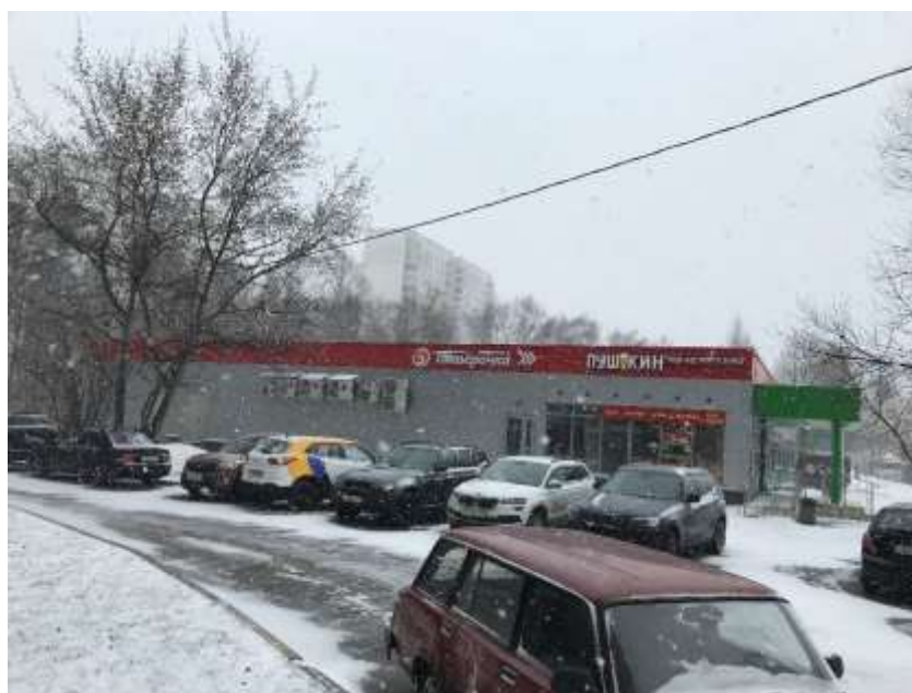
Фото 2. Внешний вид здания
