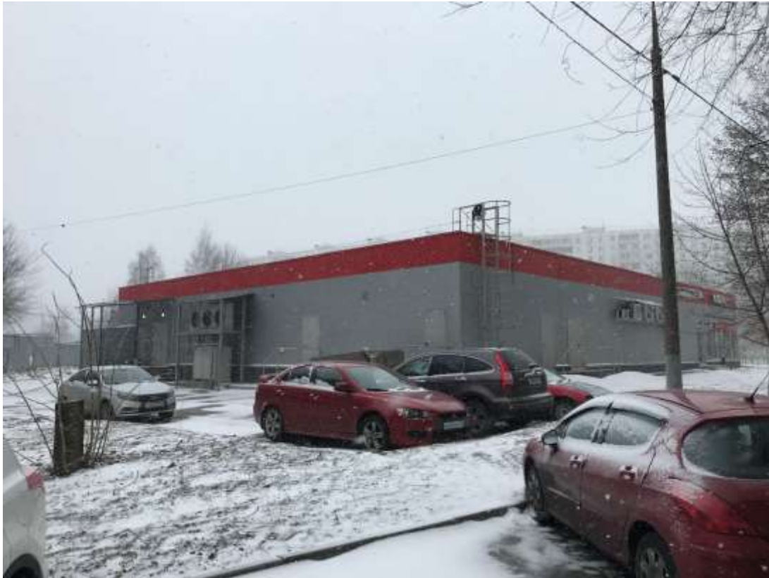
Фото 3. Внешний вид здания
