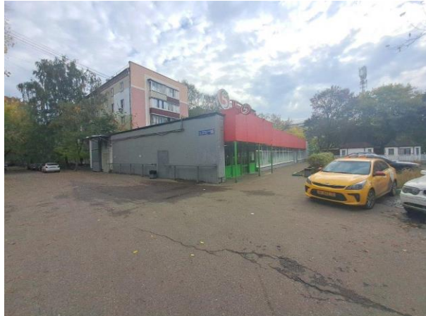
Общий вид здания
