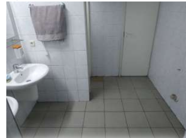
Внутренние помещения (подвал)
