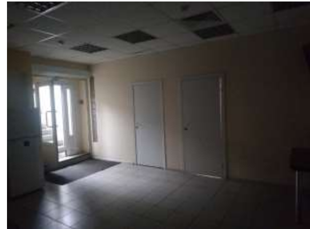
Внутренние помещения (подвал)
