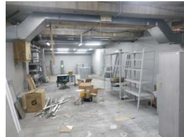
Внутренние помещения (подвал)
