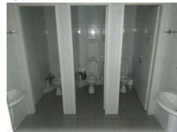
Внутренние помещения (подвал)
