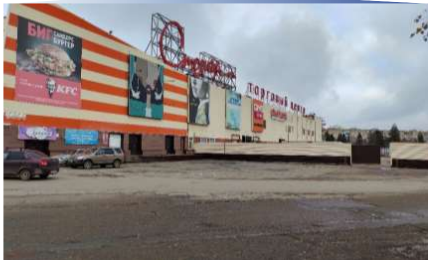
Источники: Данные визуального осмотра
