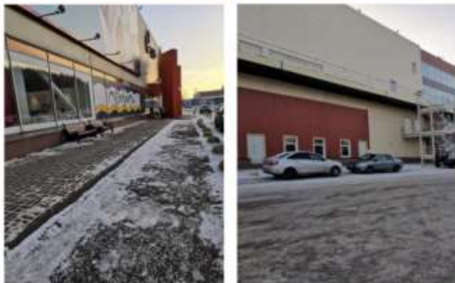
Общий вид нежилого здания, прилегающая территория.
