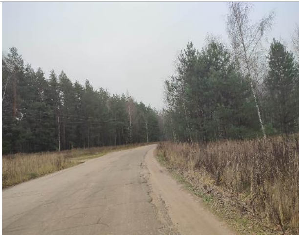
Фото 31. Подъездные пути и прилегающая территория.
