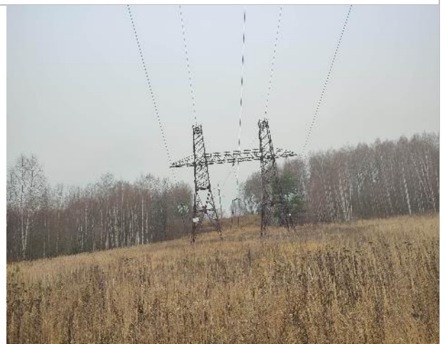
Фото 30. Подъездные пути и прилегающая территория.
