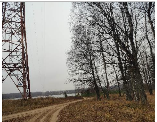
Фото 40. Подъездные пути и прилегающая территория.
