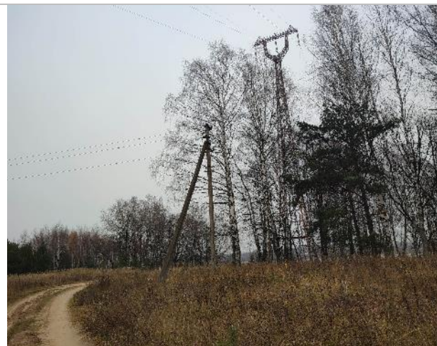
Фото 39. Подъездные пути и прилегающая территория.
