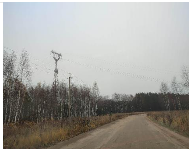
Фото 29. Подъездные пути и прилегающая территория.
