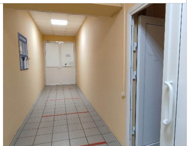
Фотография 48. 2 этаж (внутренние помещения).
