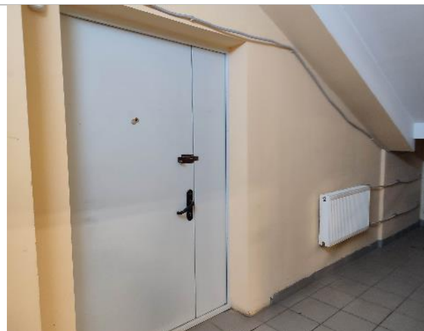
Фотография 3. 1 этаж (внутренние помещения).
