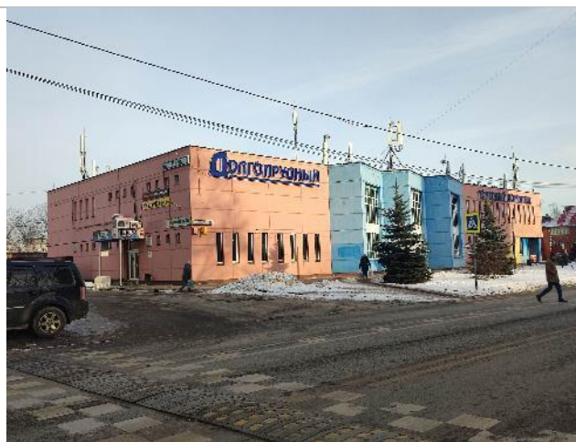
Фотография 3.3. Прилегающая территория, фасад здания
