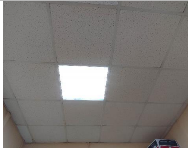
Фотография 55. 2 этаж (внутренние помещения).
