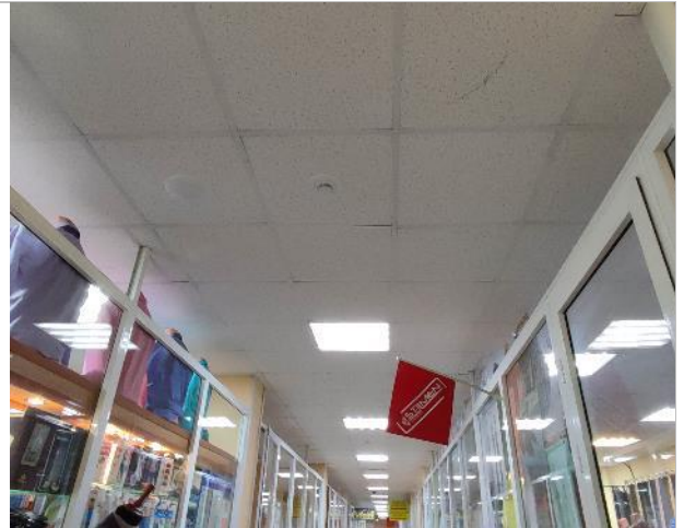
Фотография 32. 2 этаж (внутренние помещения).
