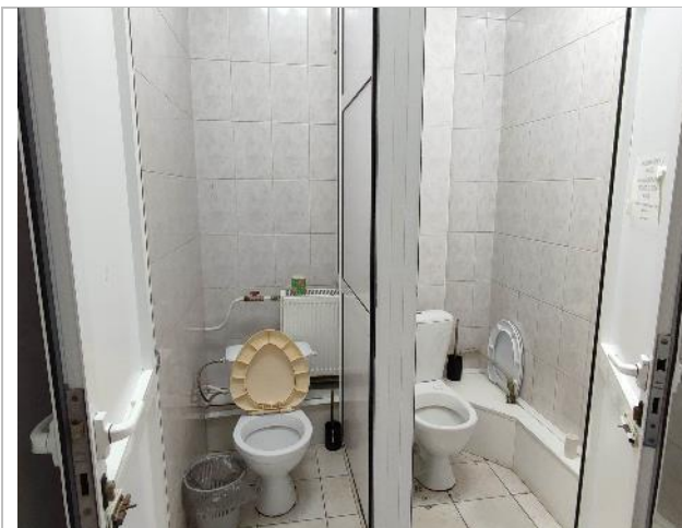
Фотография 61. 2 этаж (внутренние помещения).
