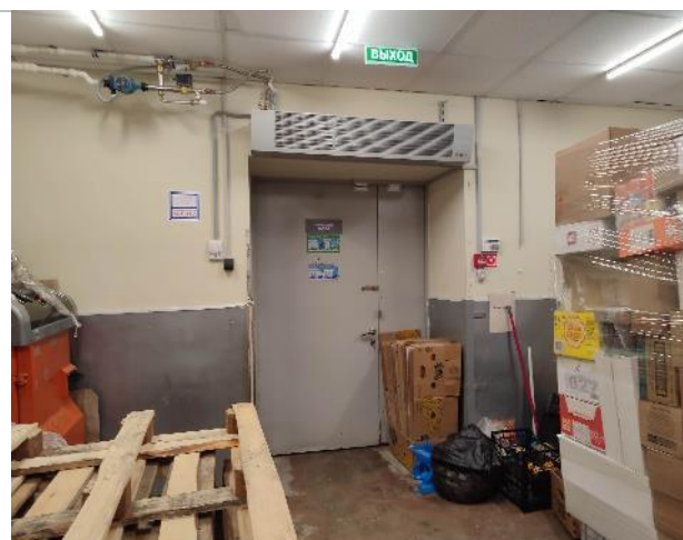
Фотография 11. 1 этаж (внутренние помещения).
