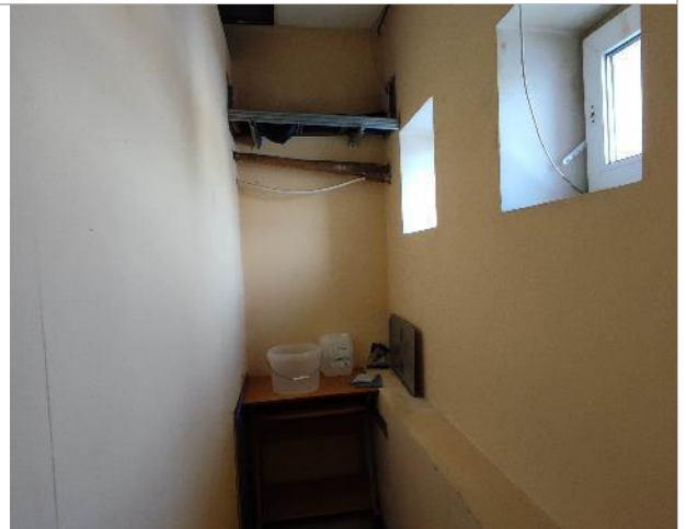
Фотография 58. 2 этаж (внутренние помещения).
