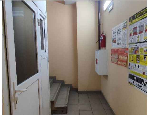
Фотография 20. 2 этаж (внутренние помещения).
