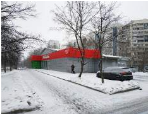
Фотография 3.3. Прилегающая территория, фасад здания
