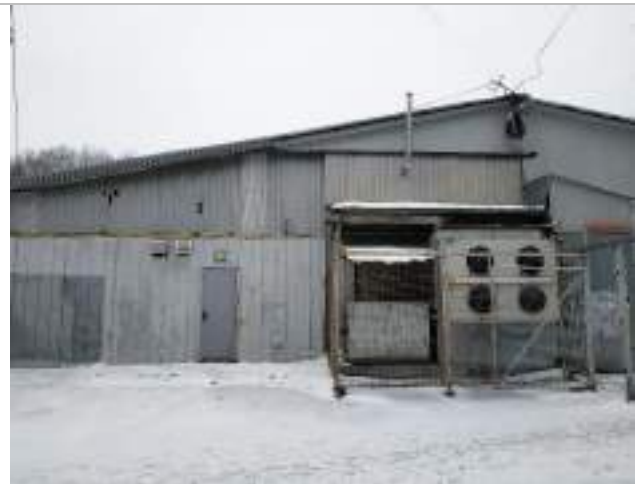
Фотография 3.4. Прилегающая территория, фасад здания
