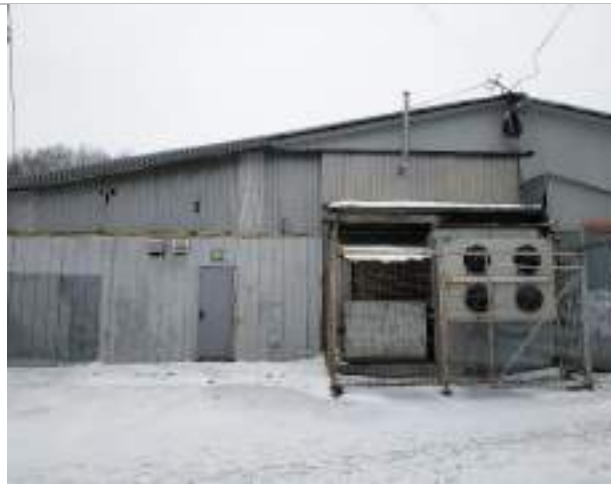
Фото 3. Внешний вид здания
