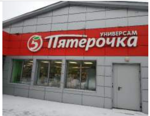
Фото 4. Внешний вид здания
