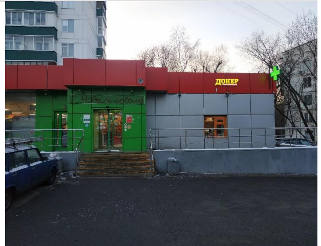
Фото 2. Фасад здания и прилегающая территория
