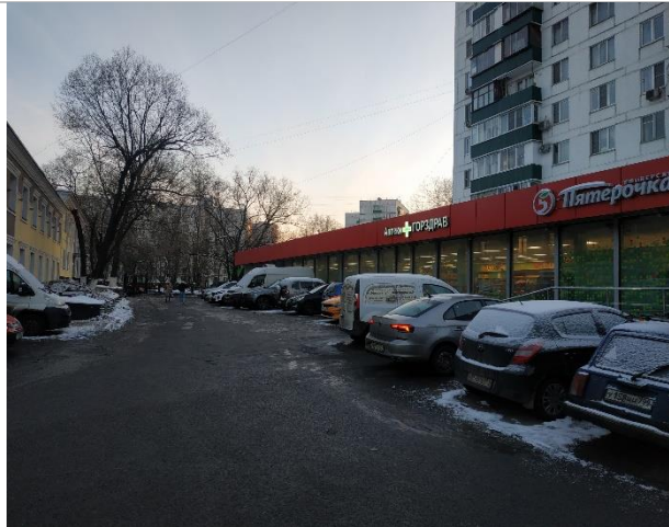
Фото 1. Фасад здания и прилегающая территория
