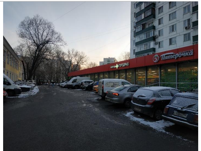
Фотография 3.4. Прилегающая территория, фасад здания
