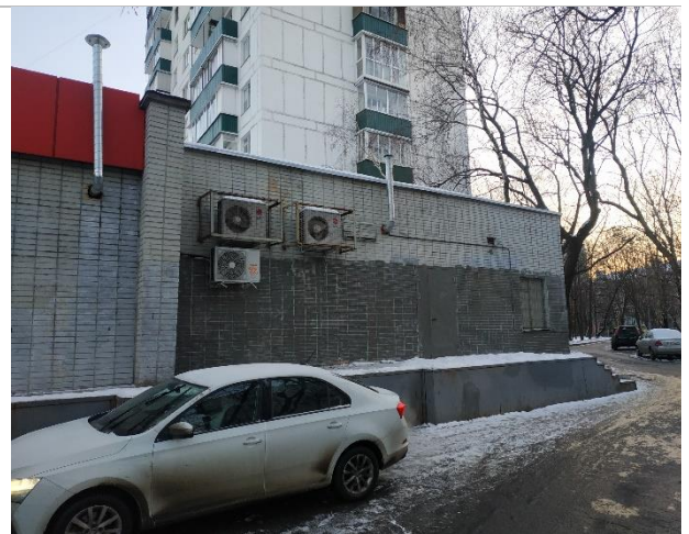
Фото 4. Фасад здания и прилегающая территория
