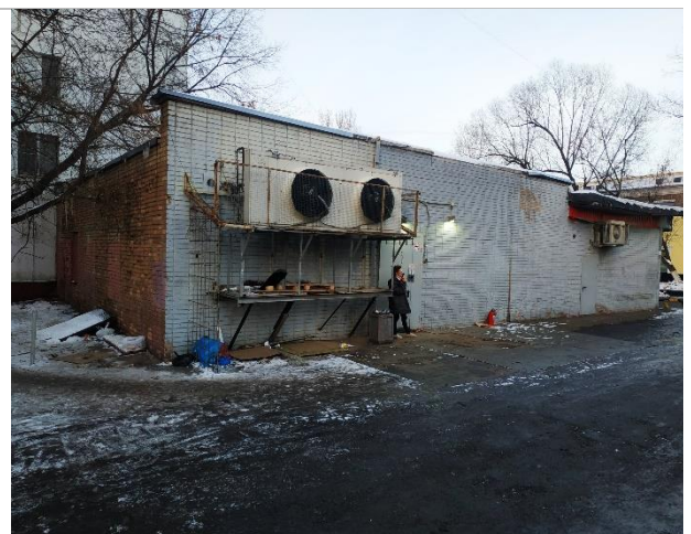
Фото 6. Фасад здания и прилегающая территория
