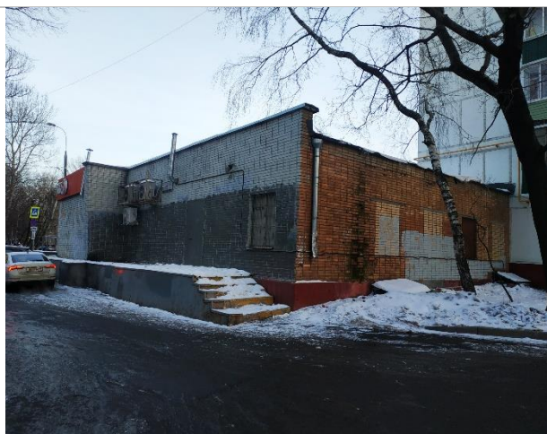
Фото 5. Фасад здания и прилегающая территория
