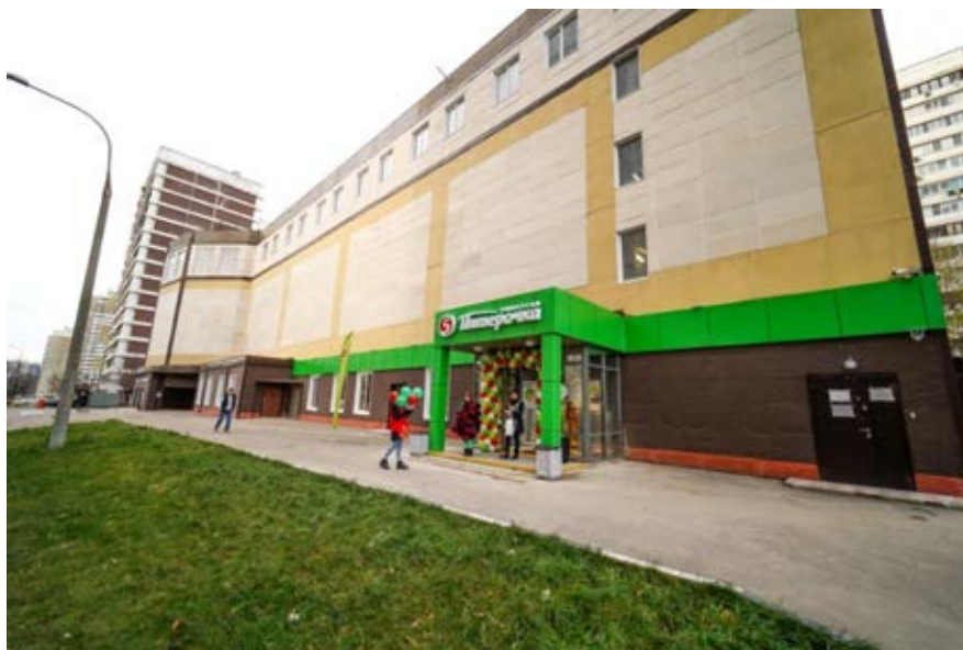
Фото 1. Внешний вид здания, вход в оцениваемые помещения
