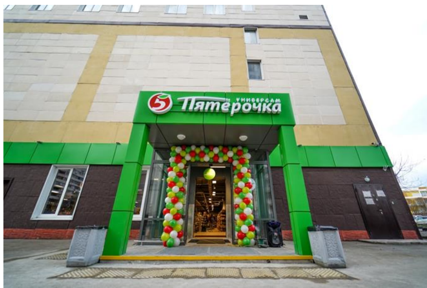
Фото 2. Внешний вид здания, вход в оцениваемые помещения
