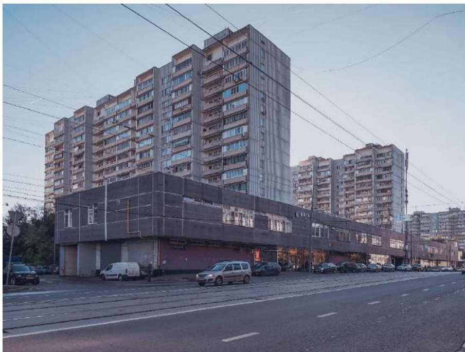
Фото 2. Внешний вид здания
