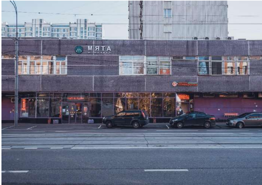
Фото 1. Внешний вид здания
