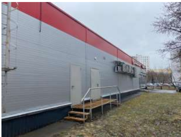
Фото 5. Внешний вид здания
