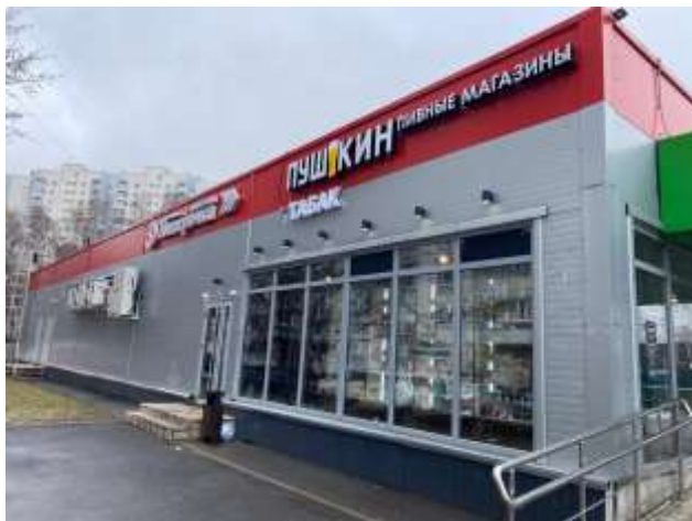
Фото 1. Внешний вид здания
