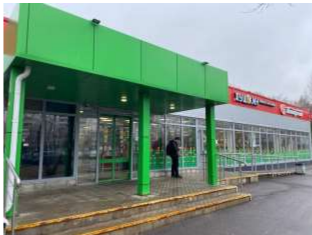
Фото 2. Внешний вид здания
