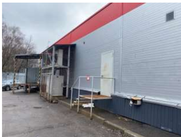
Фото 4. Внешний вид здания
