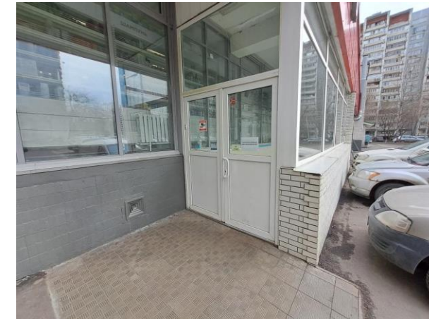
Входная группа (подвал)
