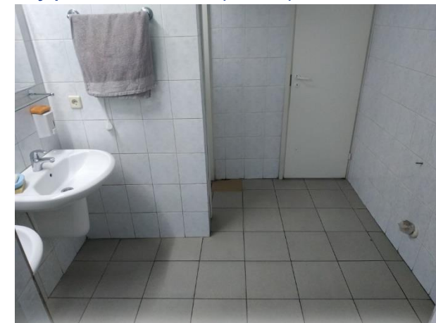
Внутренние помещения (подвал)
