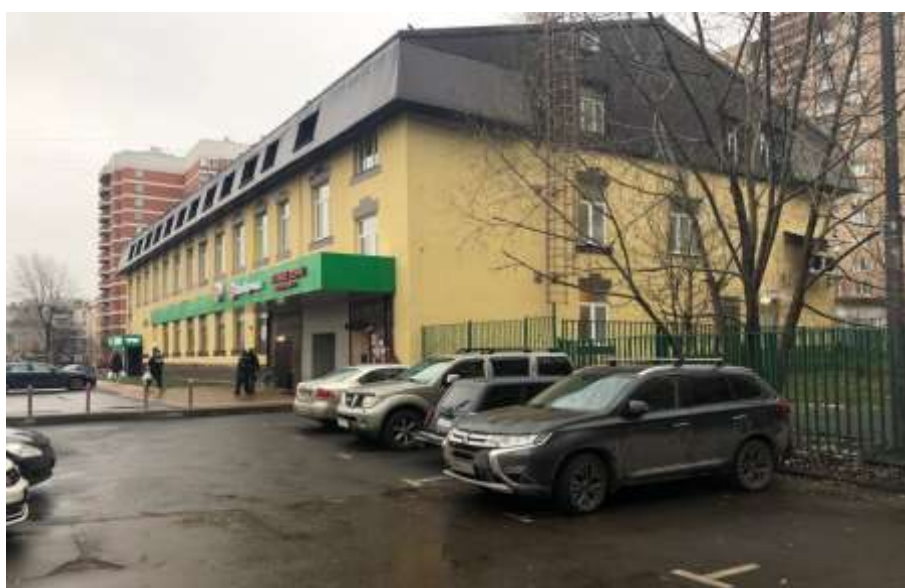
Фото 2. Внешний вид здания
