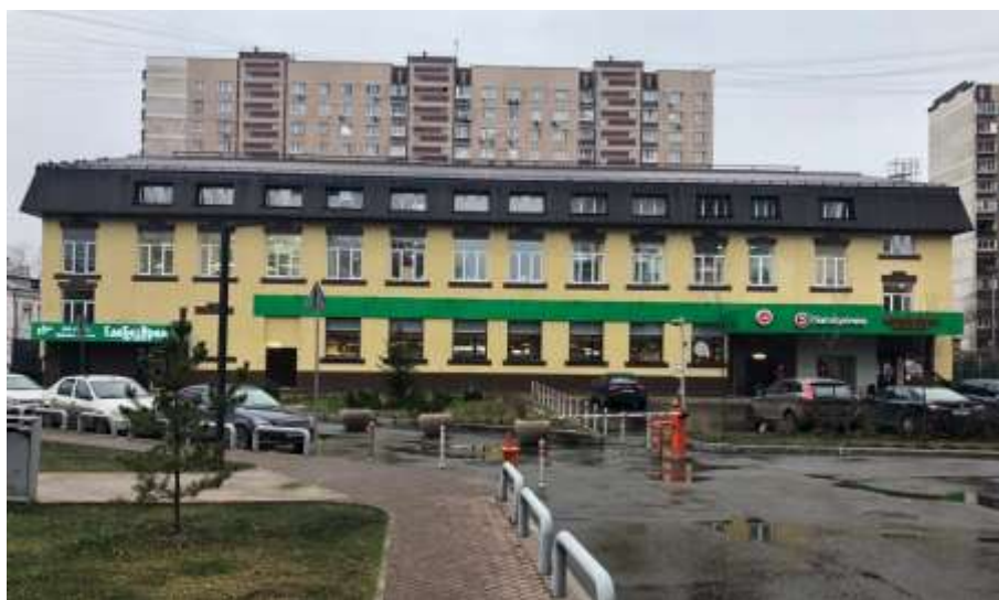
Фото 1. Внешний вид здания
