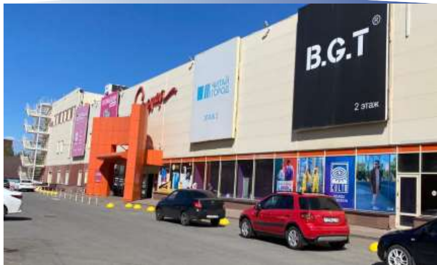
Источники: Данные визуального осмотра
