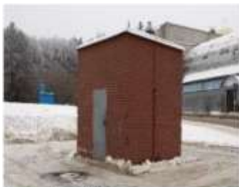
Здание КНС отдельностоящее
