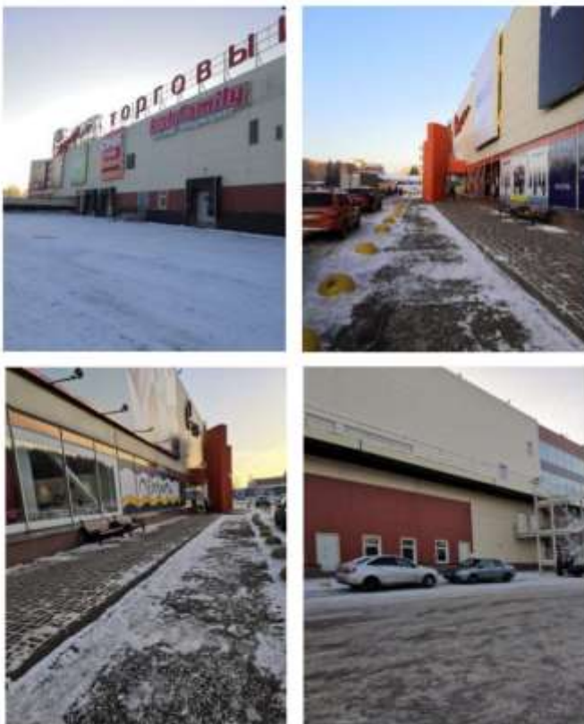
Общий вид нежилого здания, прилегающая территория.
