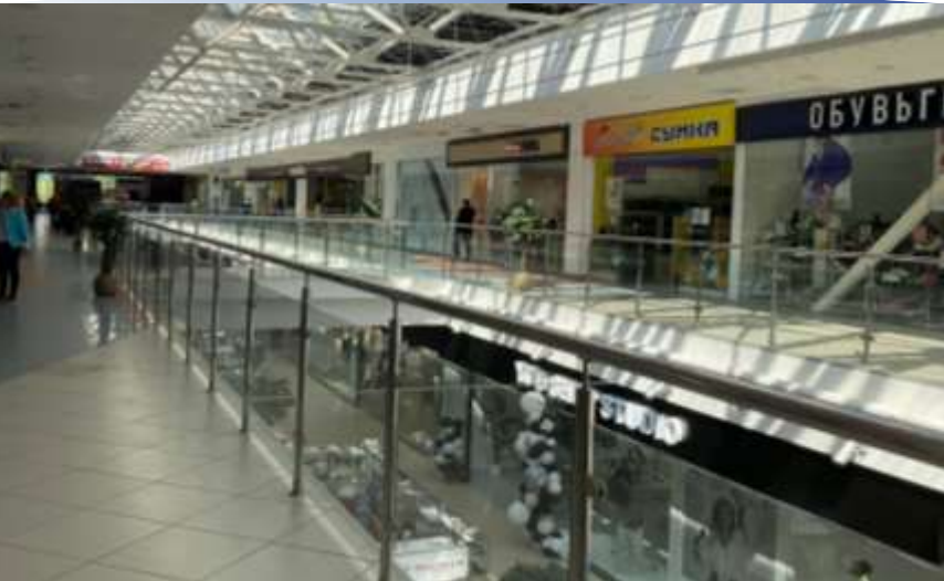
Источники: Данные визуального осмотра
