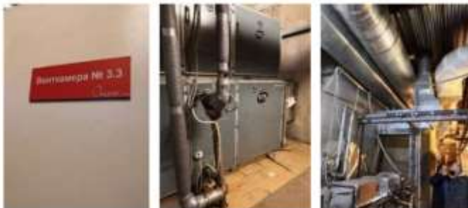
Установка приточно-вытяжной вентиляции
