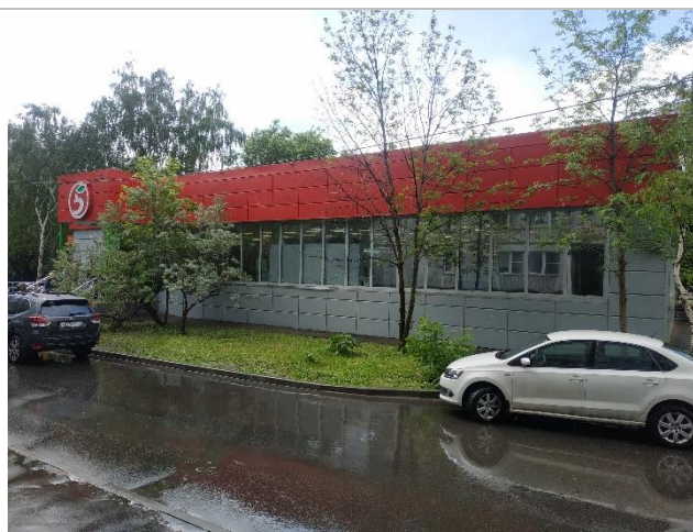
Фотография 3.3. Прилегающая территория, фасад здания
