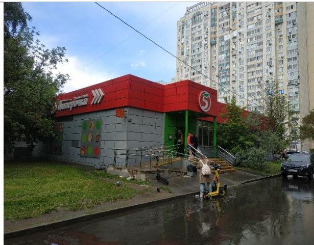
Фото 7. Фасад здания и прилегающая территория
