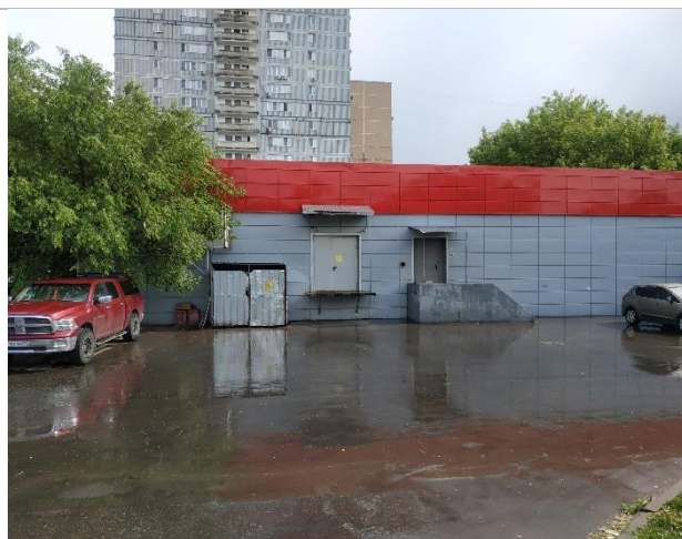
Фото 9. Фасад здания и прилегающая территория
