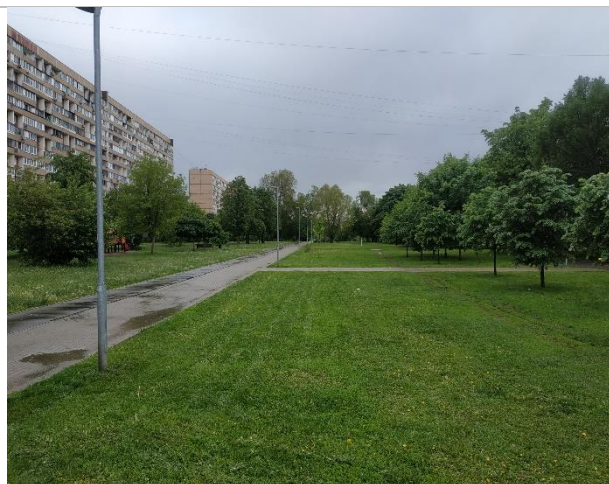
Фото 2. Прилегающая территория и подъездные пути
