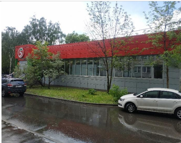
Фото 8. Фасад здания и прилегающая территория
