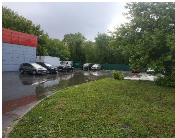
Фото 5. Фасад здания и прилегающая территория
