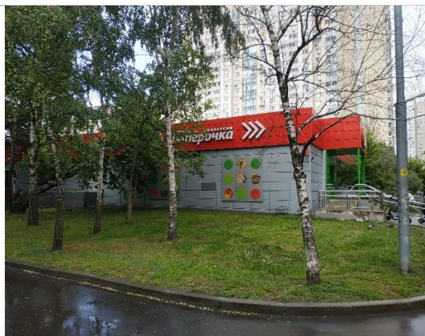
Фото 11. Фасад здания и прилегающая территория
