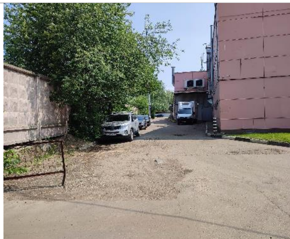
Фотография 82. Фасад здания.
