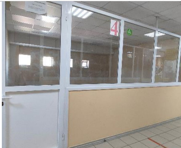
Фотография 38. 2 этаж (внутренние помещения).
