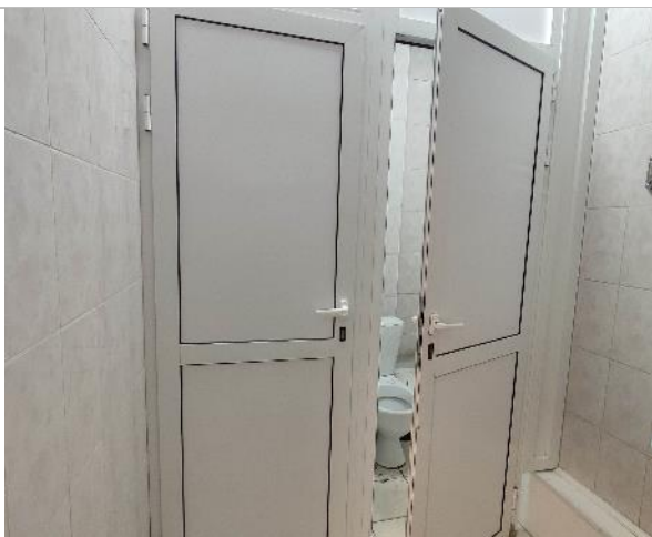
Фотография 51. 2 этаж (внутренние помещения).
