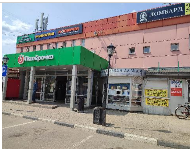
Фотография 3.4. Прилегающая территория, фасад здания
