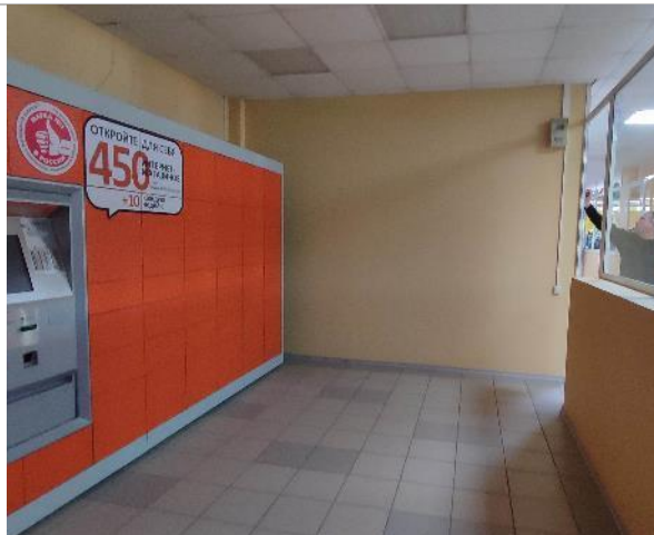
Фотография 40. 2 этаж (внутренние помещения).
