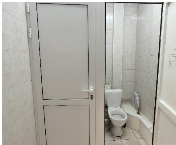
Фотография 52. 2 этаж (внутренние помещения).
