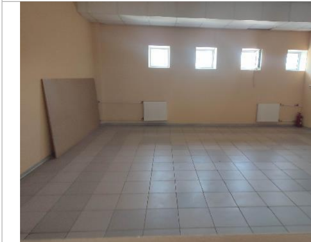
Фотография 33. 2 этаж (внутренние помещения).
