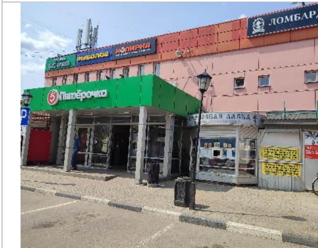
Фотография 69. Фасад здания.
