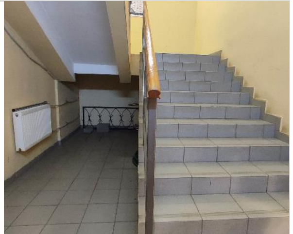
Фотография 68. 2 этаж (внутренние помещения).
