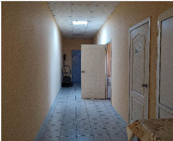
Фотография 49. 2 этаж (внутренние помещения).
