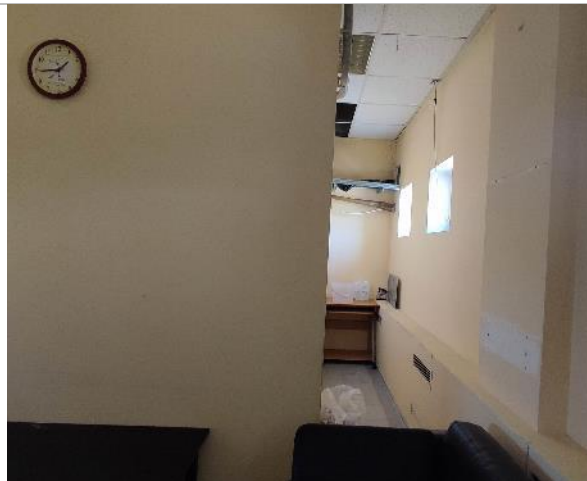
Фотография 56. 2 этаж (внутренние помещения).
