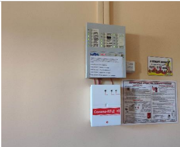
Фотография 61. 2 этаж (внутренние помещения).
