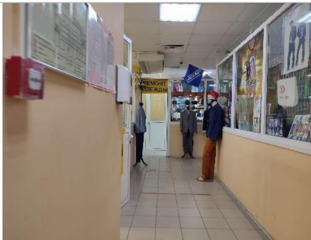
Фотография 3.8. Состояние внутренних помещений
