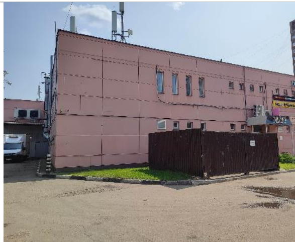
Фотография 80. Фасад здания.
