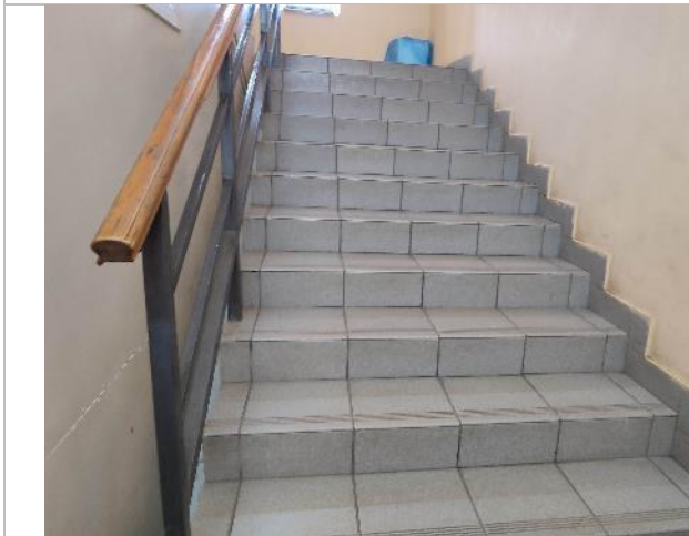
Фотография 23. 2 этаж (внутренние помещения).
