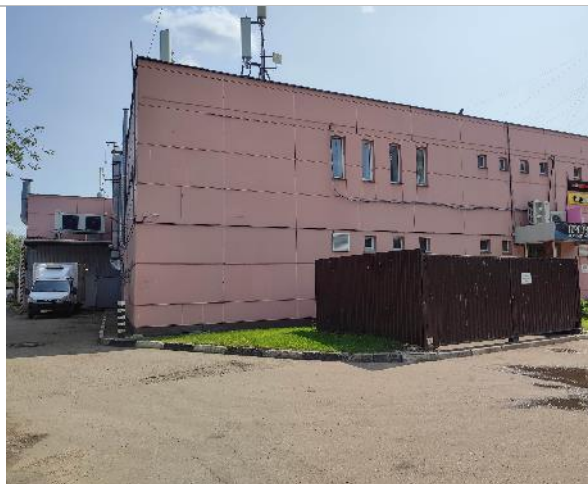
Фотография 81. Фасад здания.
