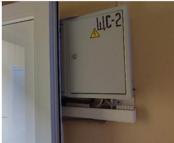
Фотография 62. 2 этаж (внутренние помещения).
