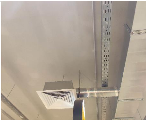
Фотография 11. 1 этаж (внутренние помещения).
