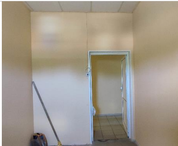
Фотография 64. 2 этаж (внутренние помещения).
