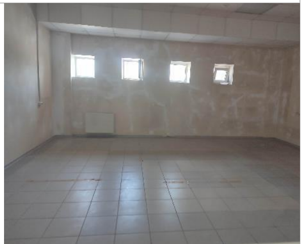
Фотография 36. 2 этаж (внутренние помещения).
