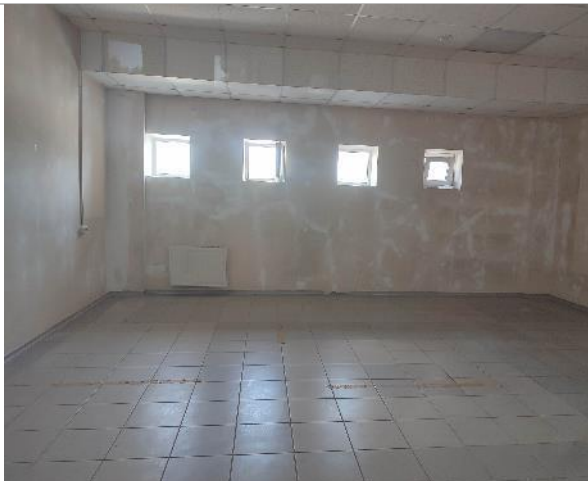
Фотография 37. 2 этаж (внутренние помещения).
