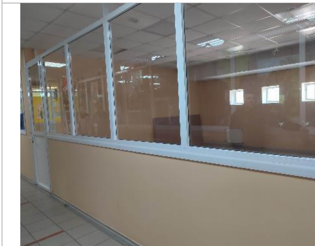
Фотография 35. 2 этаж (внутренние помещения).
