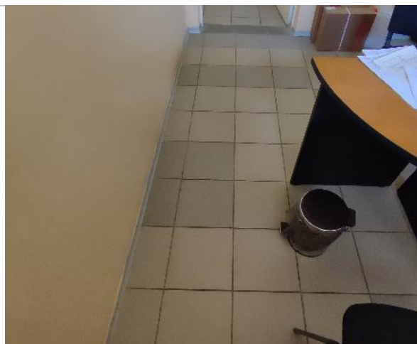
Фотография 60. 2 этаж (внутренние помещения).
