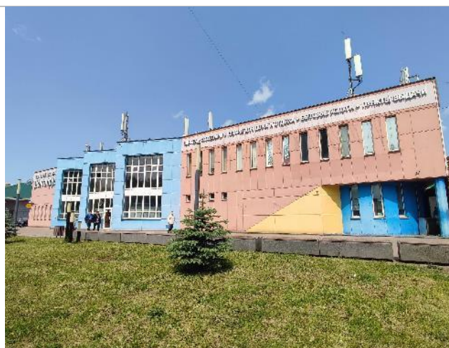
Фотография 3.3. Прилегающая территория, фасад здания
