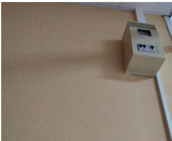
Фотография 41. 2 этаж (внутренние помещения).
