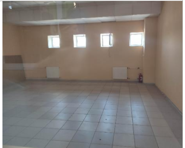
Фотография 34. 2 этаж (внутренние помещения).
