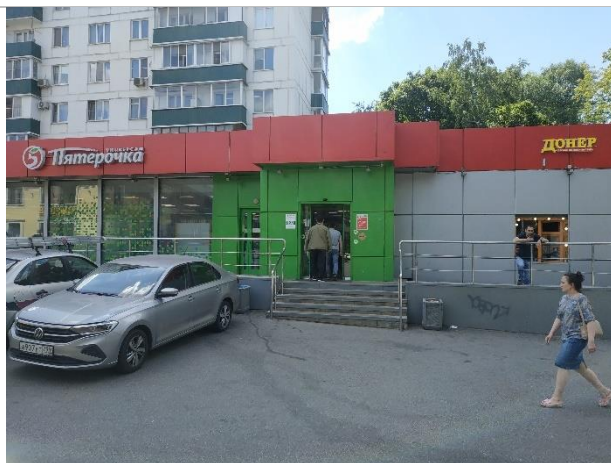
Фотография 3.3. Прилегающая территория, фасад здания
