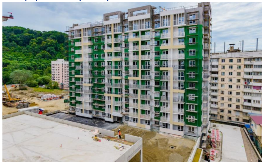
Источники: Данные визуального осмотра
