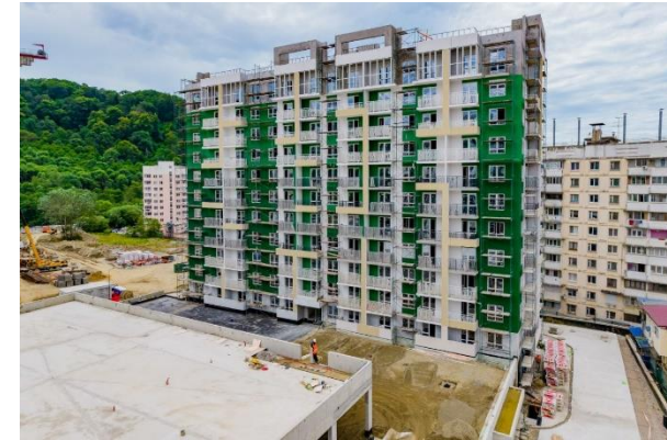
ЖК ФЛОРА, литера Л-2
