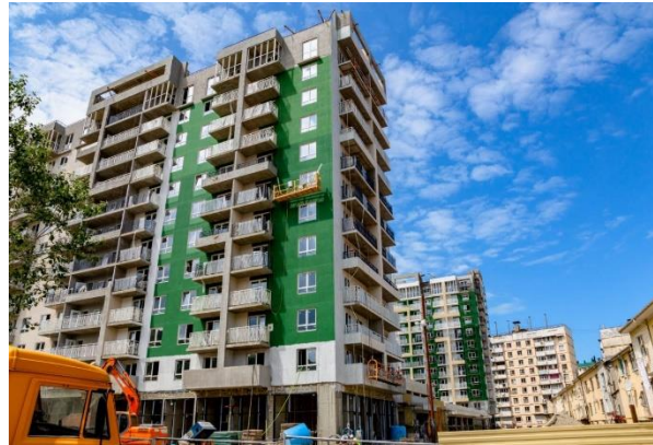
ЖК ФЛОРА, литера Л-1
