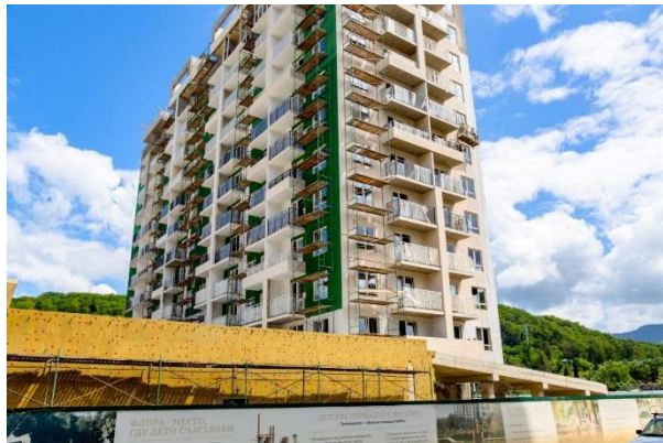
ЖК ФЛОРА, литера Л-1
