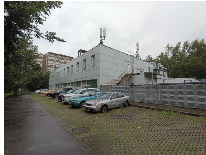
Общий вид здания площадью 2 110 кв. м, фасад здания
