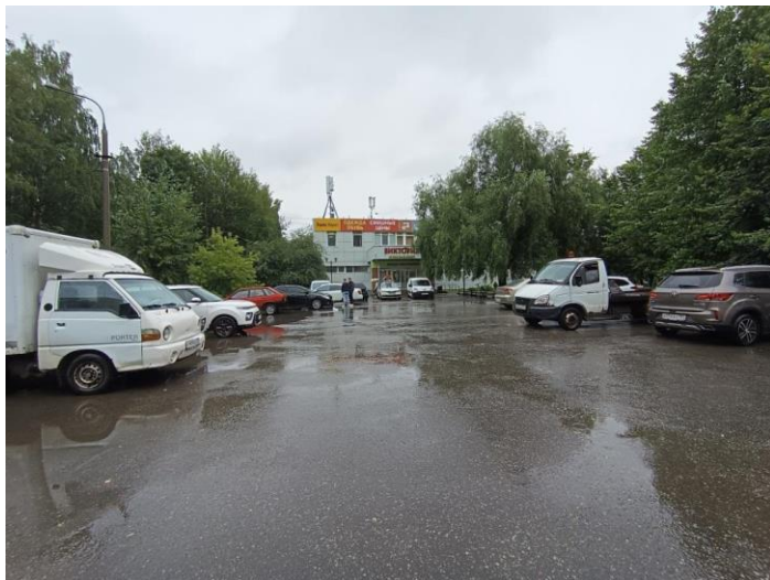
Общий вид здания площадью 2 110 кв. м, центральный вход
