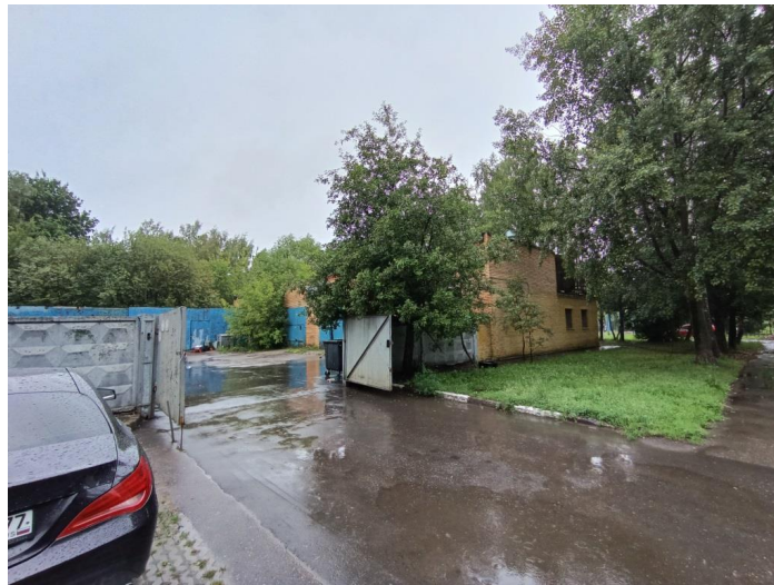
Общий вид здания котельной
