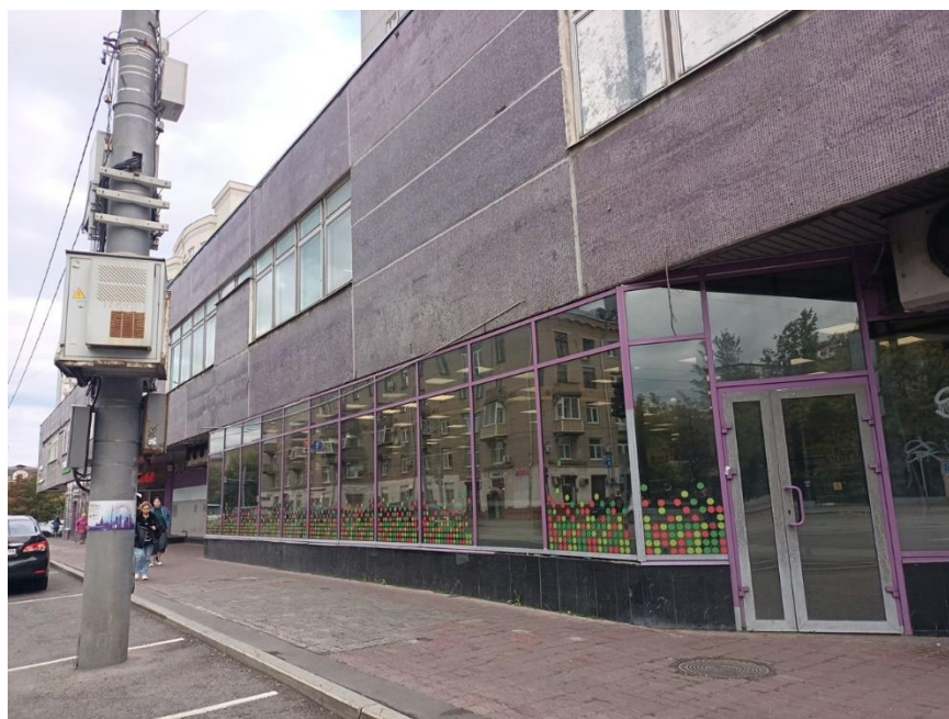
Фото 2. Внешний вид здания
