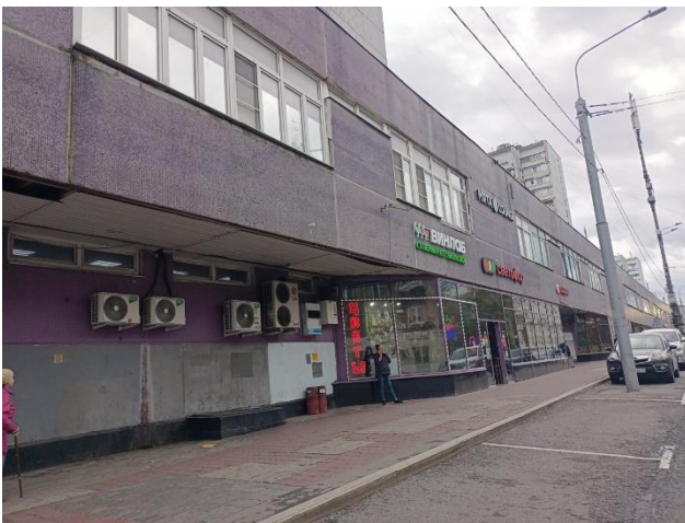
Фото 5. Внешний вид здания
