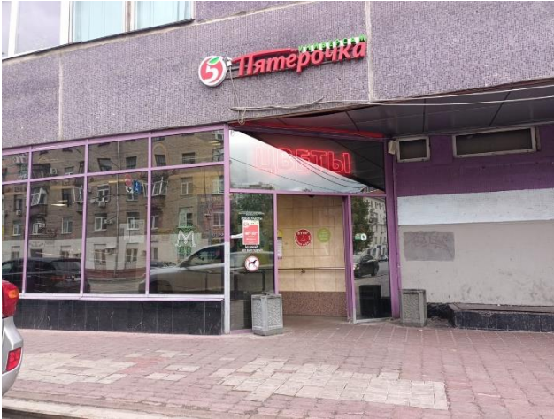
Фото 3. Внешний вид здания
