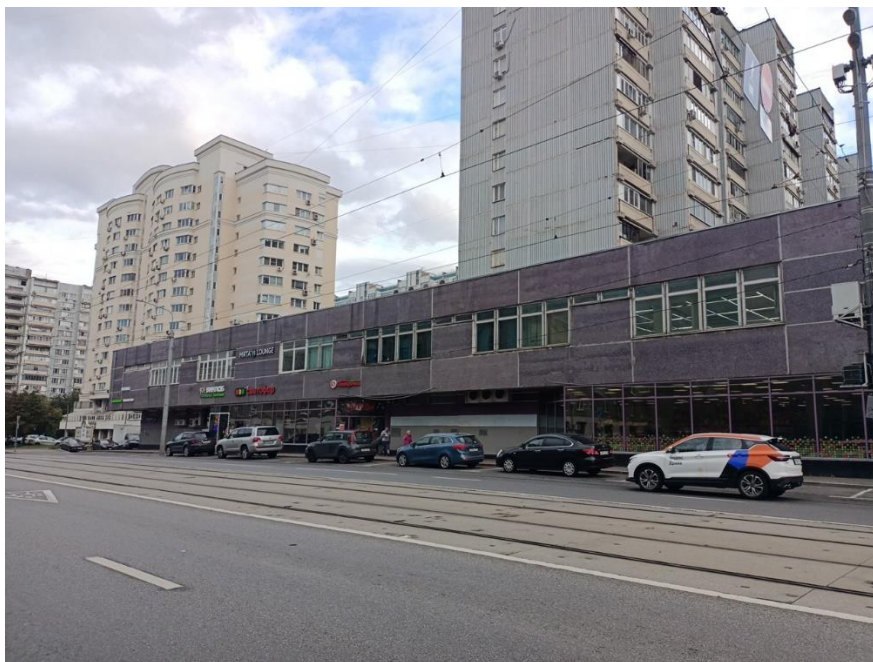
Фото 1. Внешний вид здания
