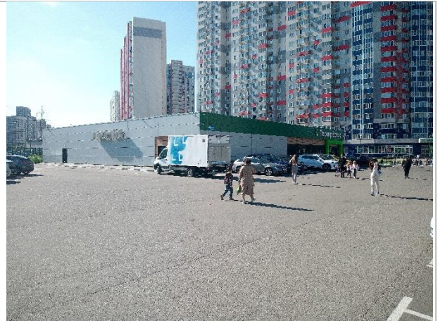
Фото 2. Внешний вид здания.
