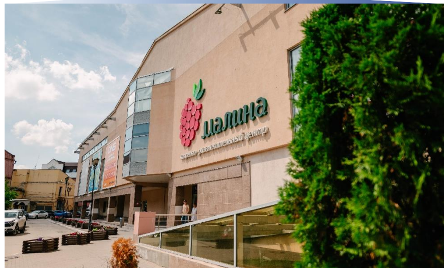
Источники: Данные визуального осмотра
