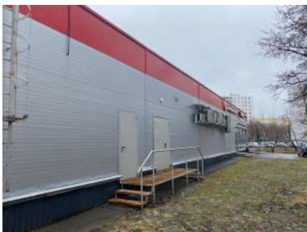
Фото 5. Внешний вид здания
