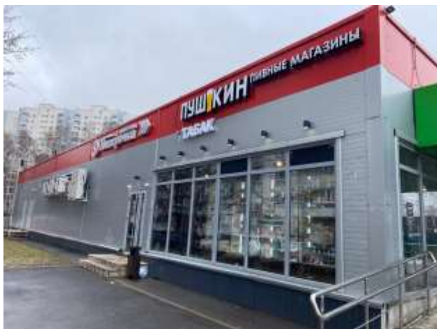
Фото 1. Внешний вид здания
