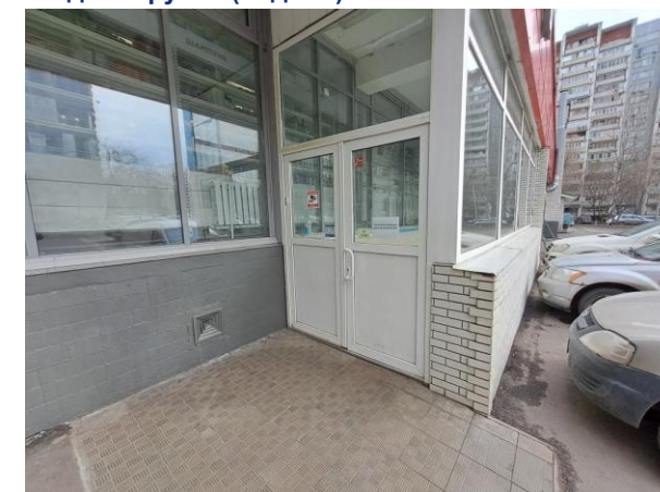
Входная группа (подвал)
