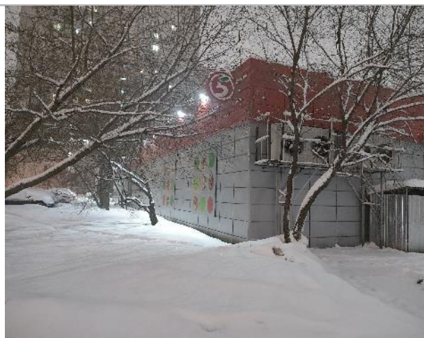
Фото 38. Фасад здания и прилегающая территория.
