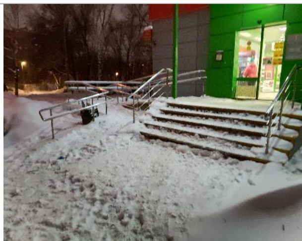
Фото 50. Фасад здания и прилегающая территория.
