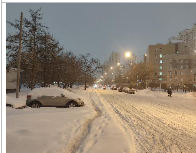
Фото 41. Фасад здания и прилегающая территория.
