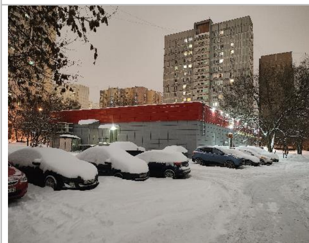
Фото 27. Фасад здания и прилегающая территория.
