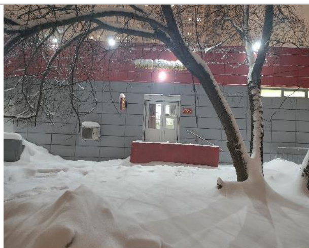
Фото 54. Фасад здания и прилегающая территория.
