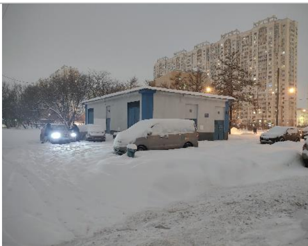
Фото 36. Фасад здания и прилегающая территория.
