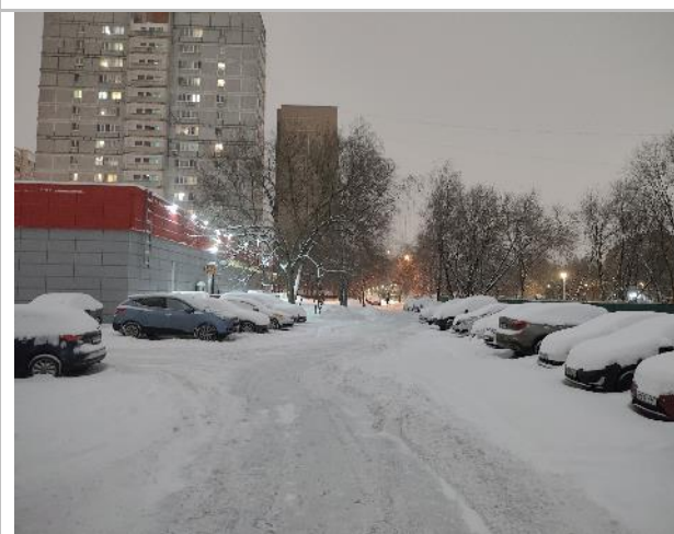
Фото 28. Фасад здания и прилегающая территория.
