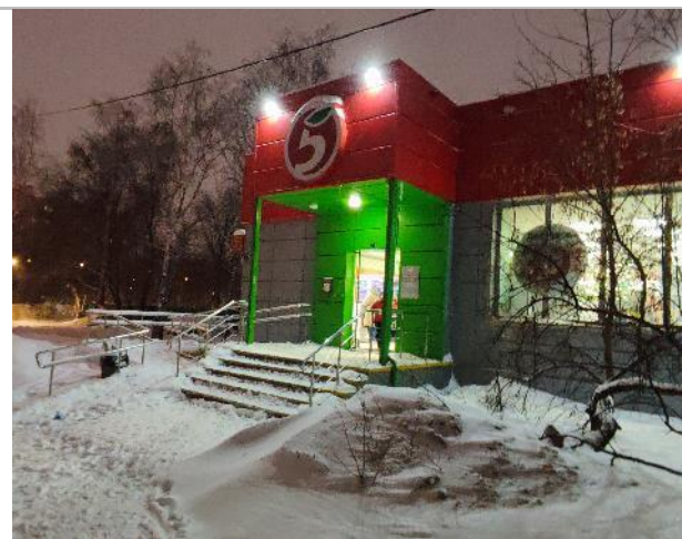
Фото 49. Фасад здания и прилегающая территория.
