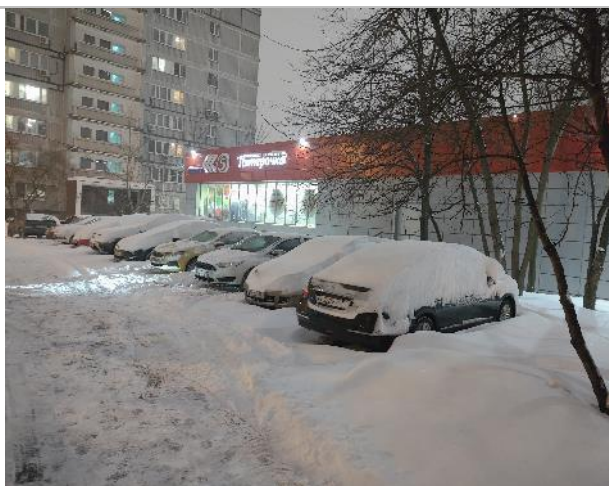
Фото 44. Фасад здания и прилегающая территория.
