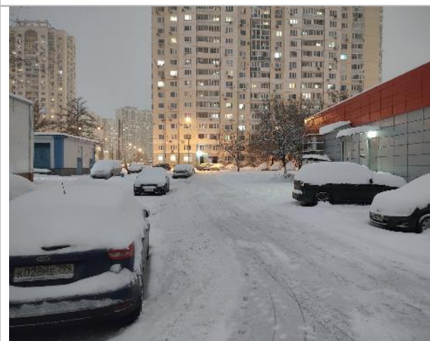
Фото 30. Фасад здания и прилегающая территория.
