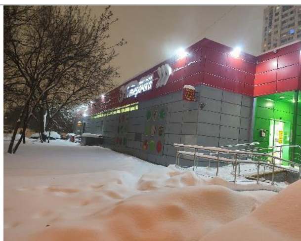
Фото 52. Фасад здания и прилегающая территория.
