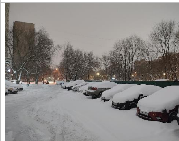
Фото 29. Фасад здания и прилегающая территория.
