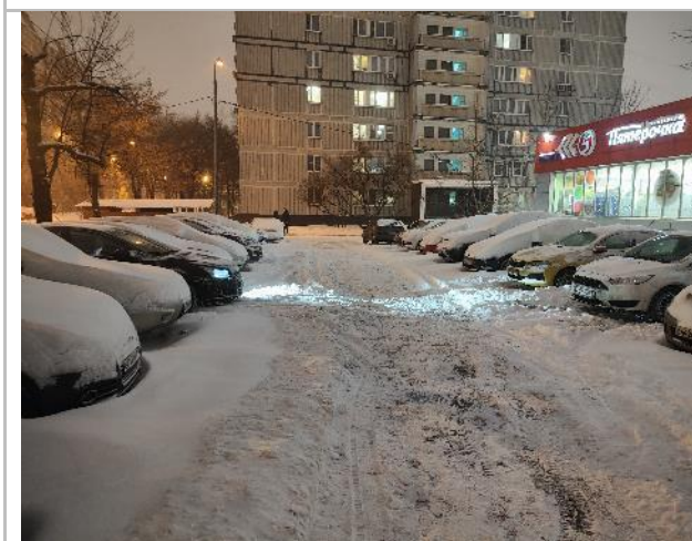
Фото 45. Фасад здания и прилегающая территория.
