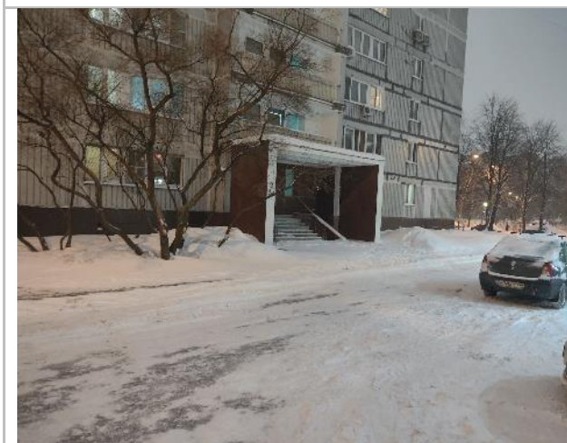
Фото 47. Фасад здания и прилегающая территория.
