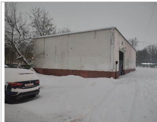
Фото 37. Фасад здания и прилегающая территория.
