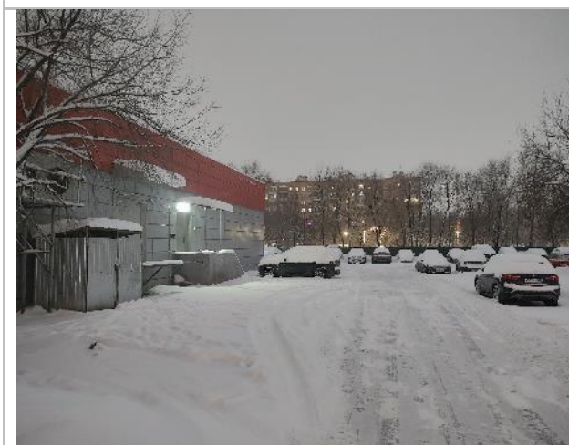
Фото 39. Фасад здания и прилегающая территория.
