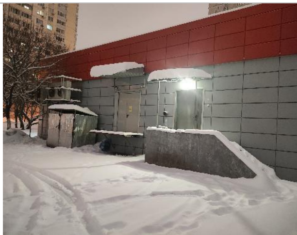
Фото 33. Фасад здания и прилегающая территория.
