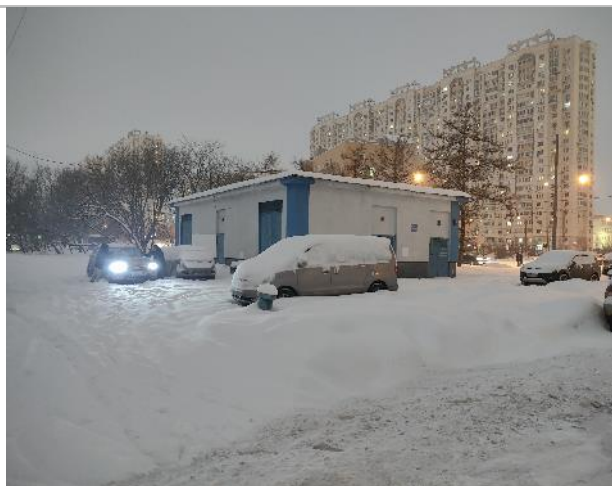
Фото 35. Фасад здания и прилегающая территория.
