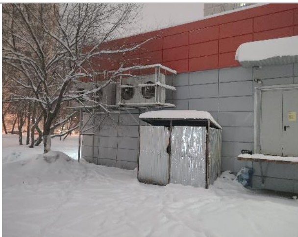
Фото 34. Фасад здания и прилегающая территория.
