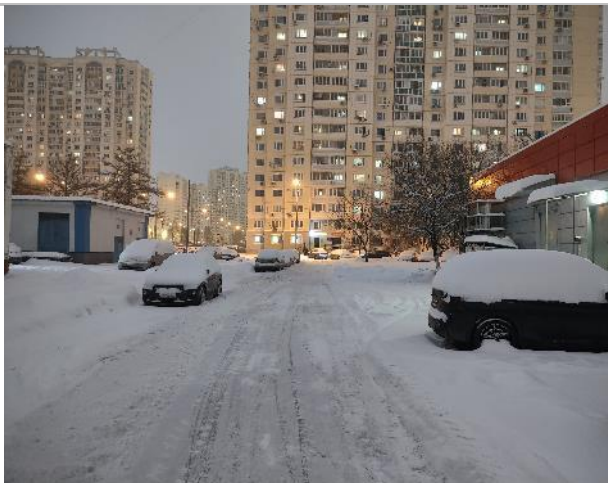
Фото 32. Фасад здания и прилегающая территория.
