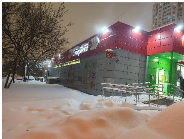
Фотография 3.3. Прилегающая территория, фасад здания
