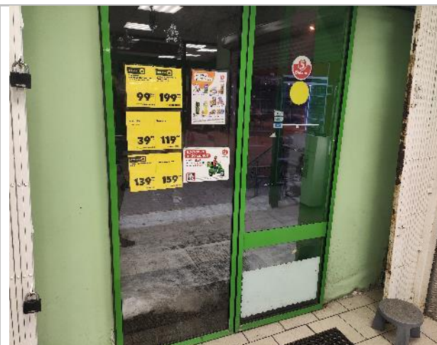
Фото 26. Внутренние помещения здания.
