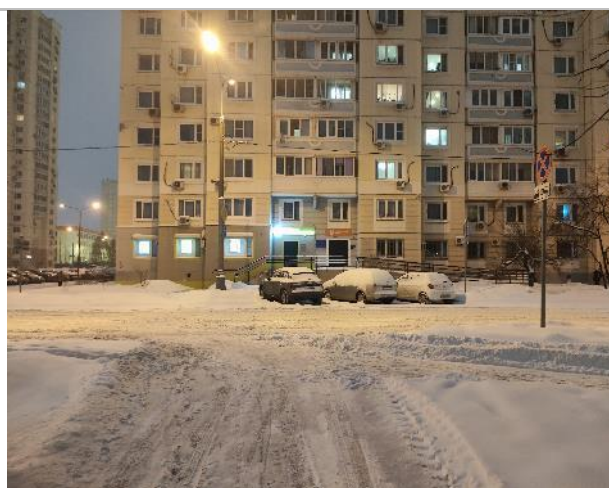
Фото 40. Фасад здания и прилегающая территория.
