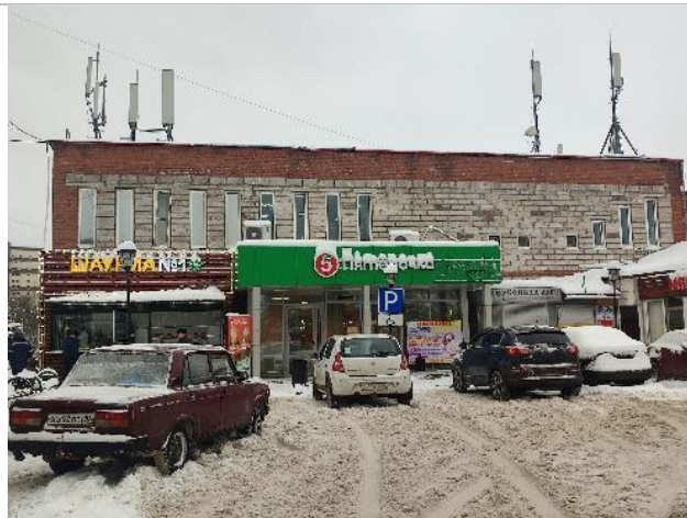
Фотография 3.3. Прилегающая территория, фасад здания
