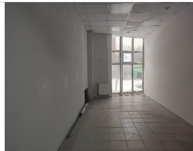
Фото 47. Помещения 2-го этажа
