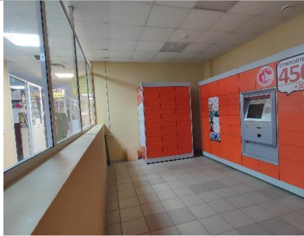
Фотография 3.11. Состояние внутренних помещений 2-го этажа
