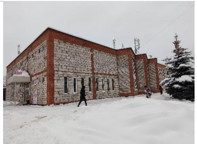
Фотография 3.4. Прилегающая территория, фасад здания
