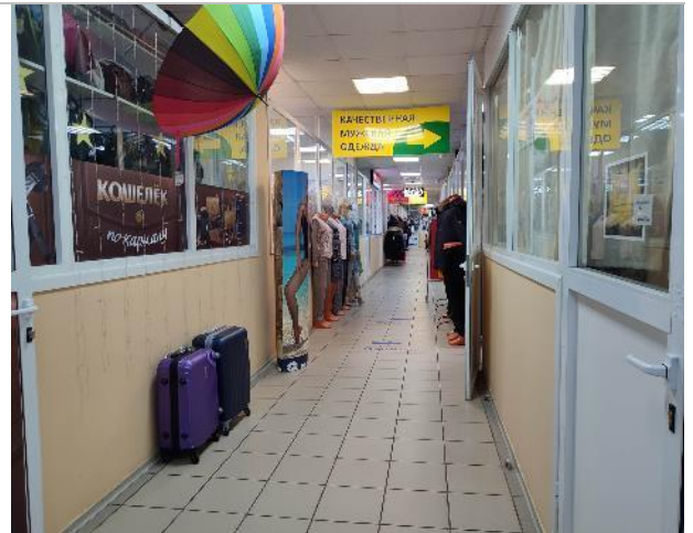
Фото 44. Помещения 2-го этажа
