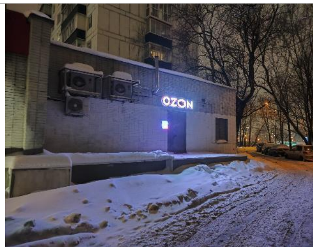
Фото 25. Фасад здания и прилегающая территория.
