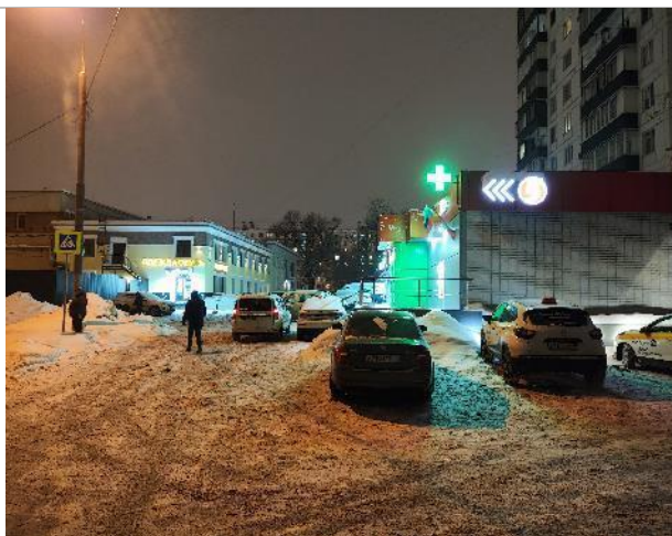
Фото 24. Фасад здания и прилегающая территория.
