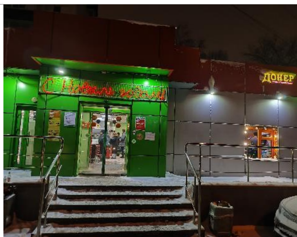
Фото 42. Фасад здания и прилегающая территория.
