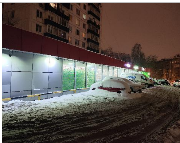
Фото 40. Фасад здания и прилегающая территория.
