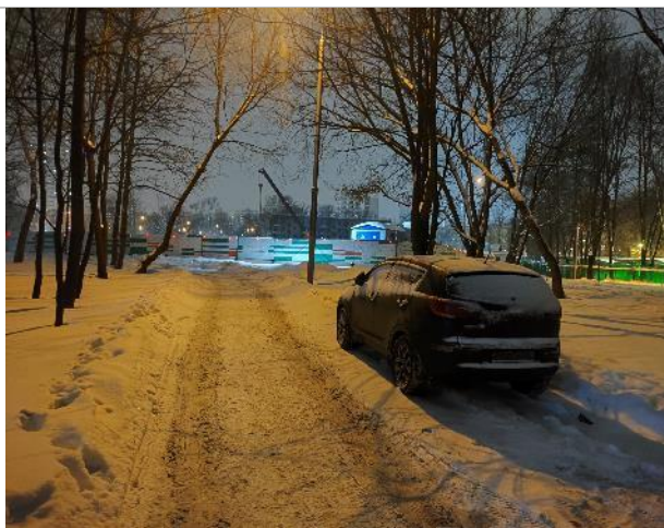
Фото 32. Фасад здания и прилегающая территория.
