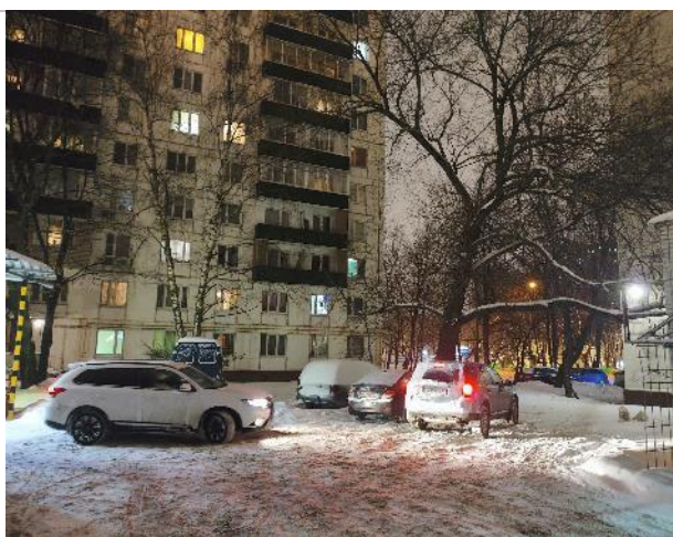
Фото 36. Фасад здания и прилегающая территория.
