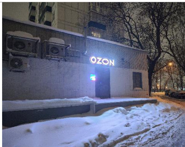
Фото 26. Фасад здания и прилегающая территория.
