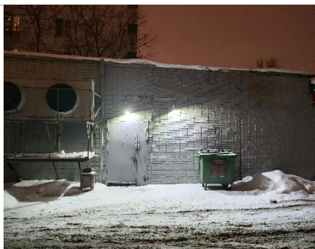
Фото 35. Фасад здания и прилегающая территория.
