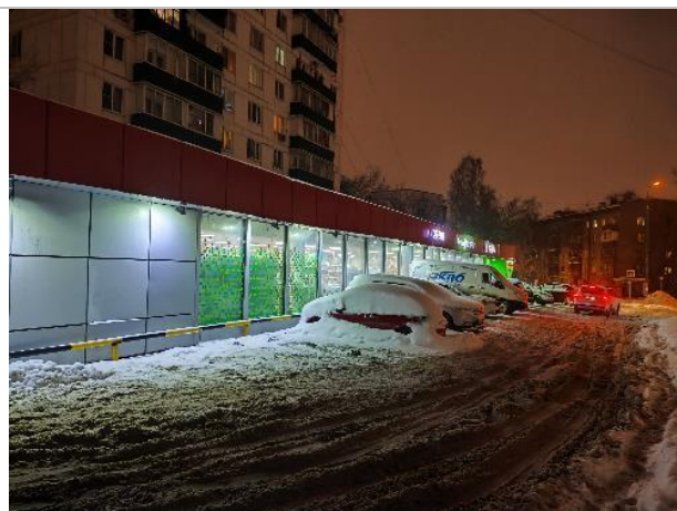
Фотография 3.4. Прилегающая территория, фасад здания
