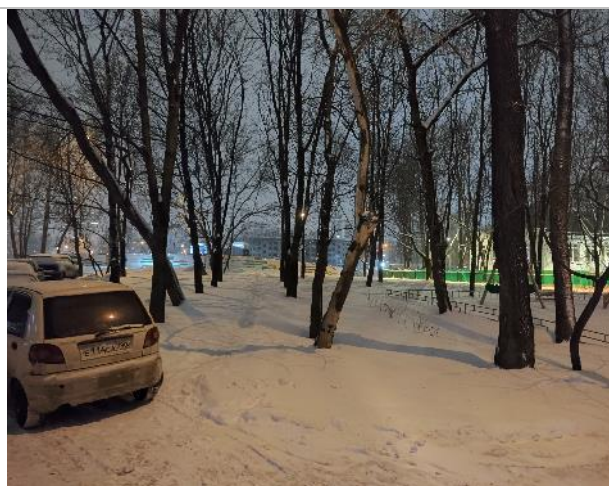
Фото 28. Фасад здания и прилегающая территория.
