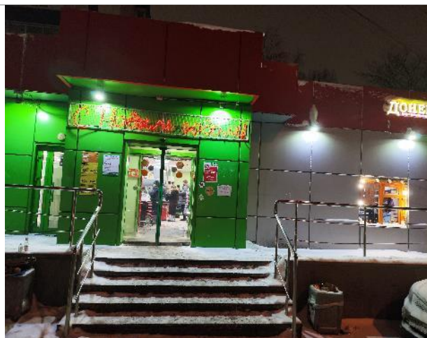
Фото 44. Фасад здания и прилегающая территория.
