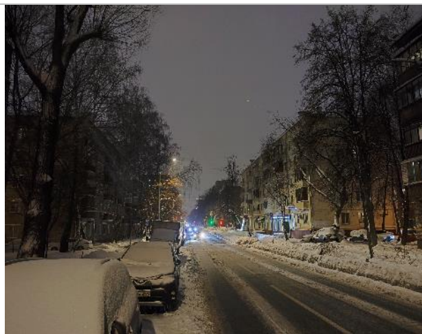
Фото 21. Фасад здания и прилегающая территория.
