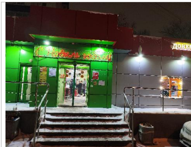
Фото 43. Фасад здания и прилегающая территория.
