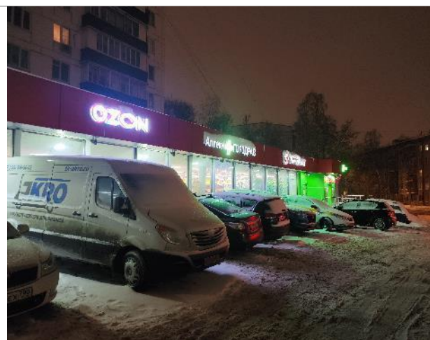
Фото 41. Фасад здания и прилегающая территория.
