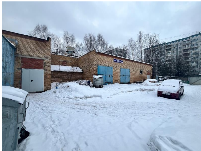
Общий вид здания котельной
