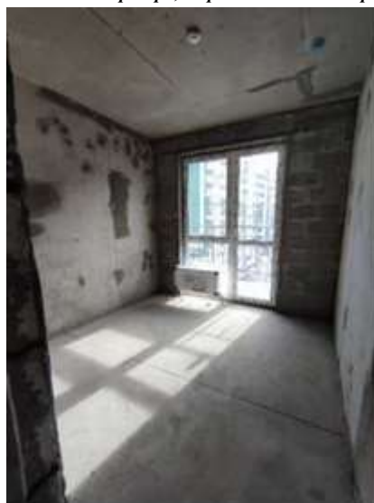
Фото № 46. Квартира, строительный номер - 57
