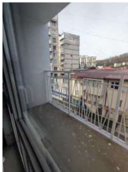
Фото № 38. Квартира, строительный номер - 18
