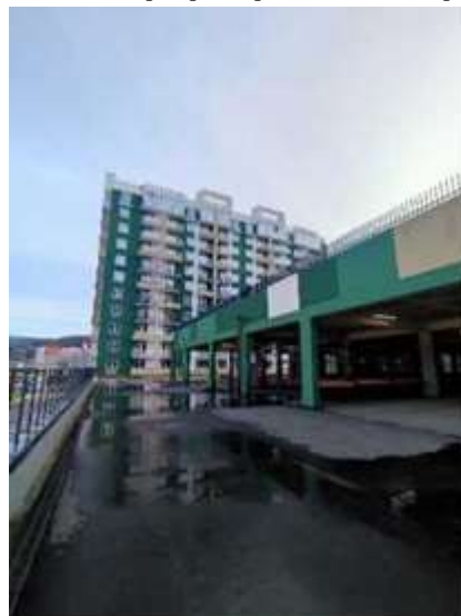
Фото № 54. Фасад здания Литер-2
