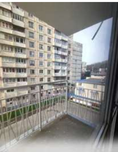
Фото № 35. Квартира, строительный номер - 17
