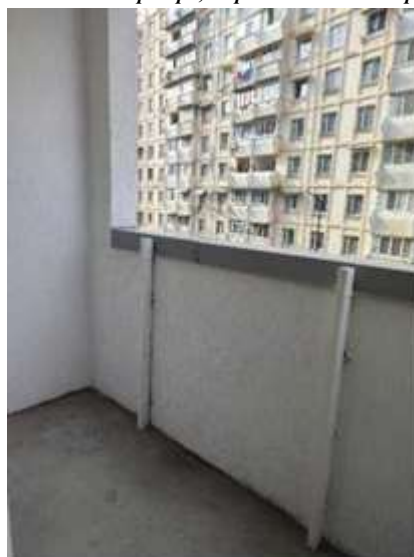
Фото № 18. Квартира, строительный номер - 3
