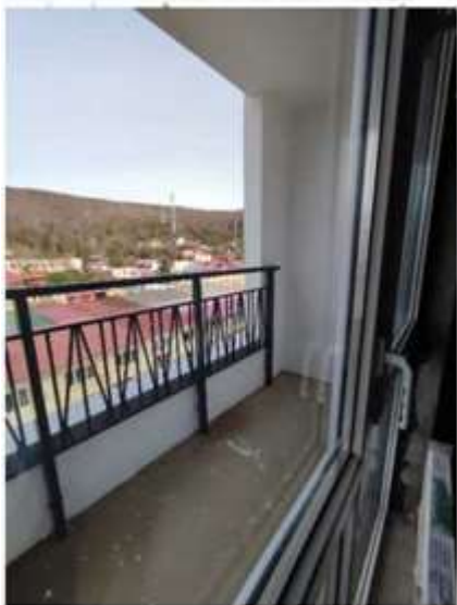
Фото № 77. Квартира, строительный номер-80
