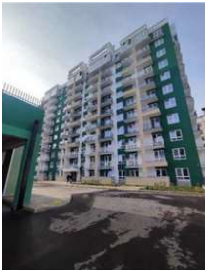
Фото № 1. Фасад здания Литер-1
