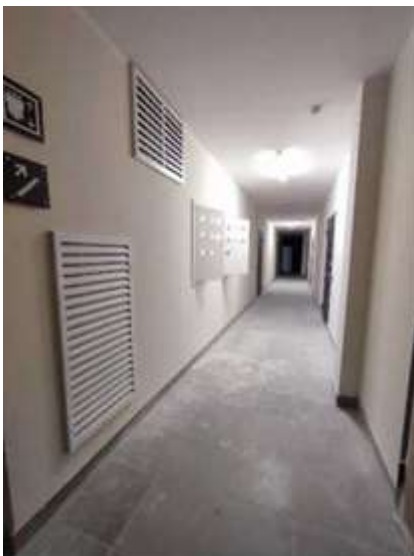
Фото № 9. Лестничная площадка
