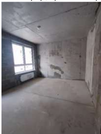
Фото № 29. Квартира, строительный номер - 12
