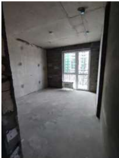
Фото № 76. Квартира, строительный номер-80
