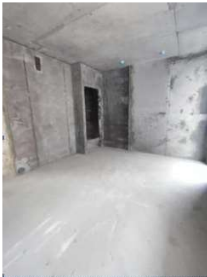
Фото № 43. Квартира, строительный номер - 27
