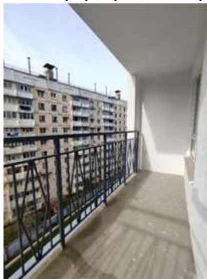
Фото № 48. Квартира, строительный номер - 57
