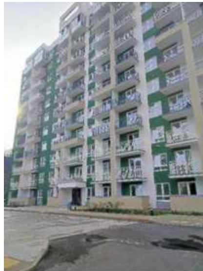
Фото № 2. Фасад здания Литер-1
