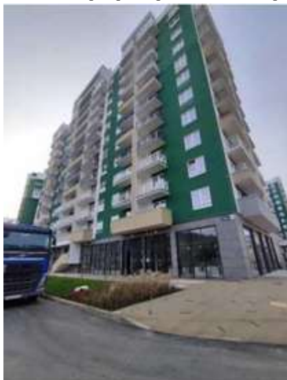
Фото № 53. Фасад здания Литер-2
