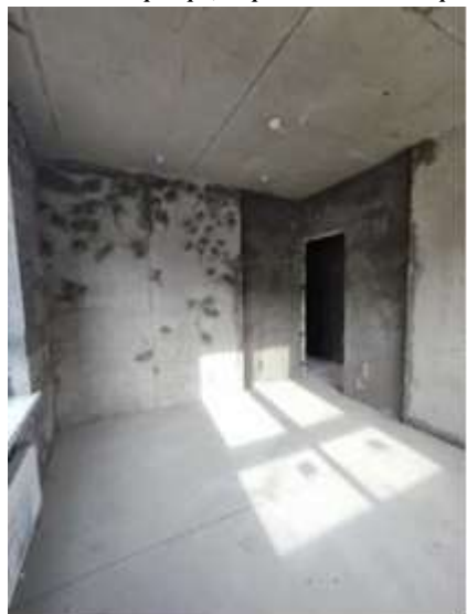
Фото № 47. Квартира, строительный номер - 57
