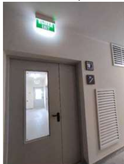
Фото № 10. Лестничная площадка
