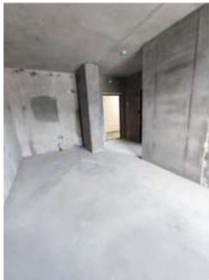
Фото № 68. Квартира, строительный номер - 15
