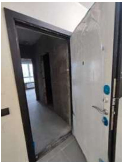
Фото № 63. Квартира, строительный номер - 12
