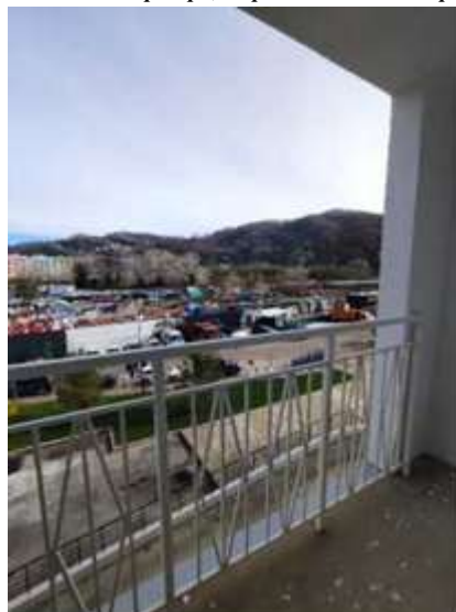
Фото № 70. Квартира, строительный номер - 15
