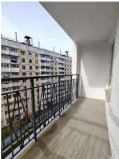
Фото № 51. Квартира, строительный номер - 72
