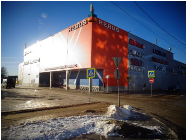
Фото № 1. Общий вид здания
