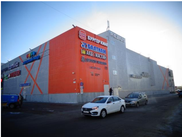
Фото № 3. Общий вид здания
