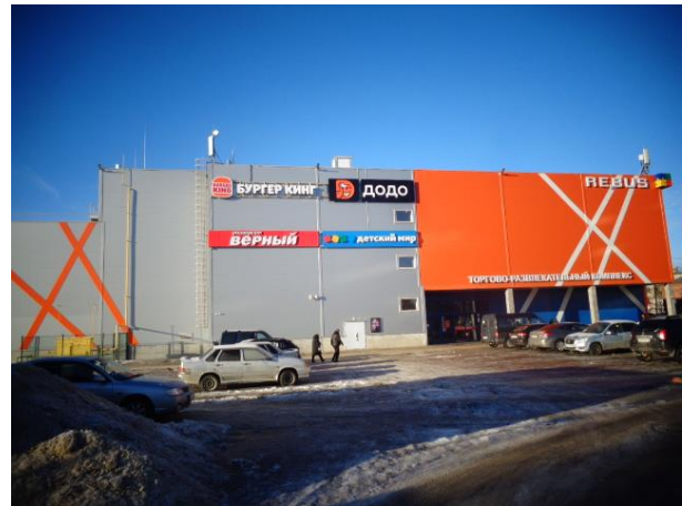
Фото № 4. Общий вид здания
