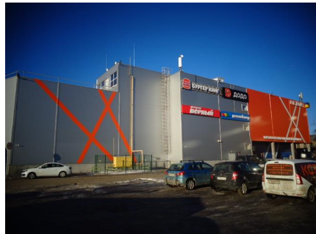
Фото № 6. Общий вид здания
