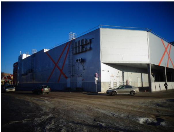
Фото № 5. Общий вид здания
