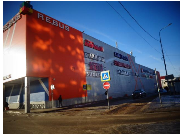
Фото № 2. Общий вид здания
