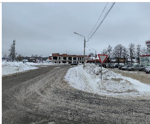
Фото 10. Фасад и прилегающая территория.
