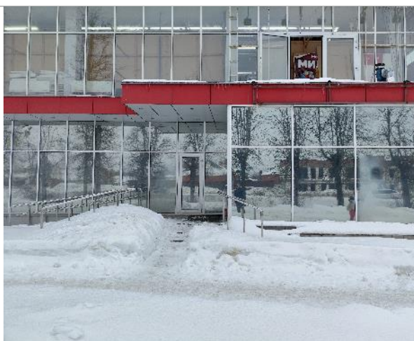
Фото 16. Фасад и прилегающая территория.
