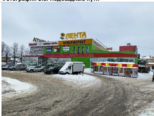
Фотография 3.3. Прилегающая территория, фасад здания
