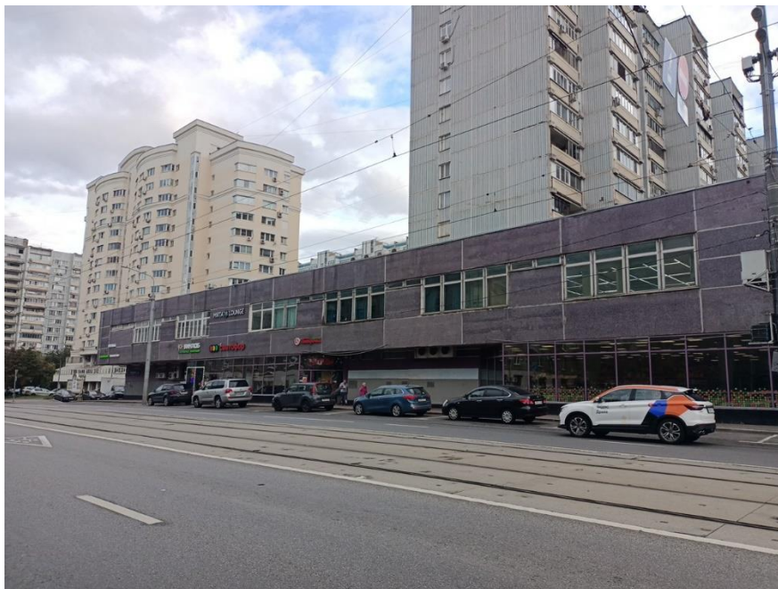
Фото 1. Внешний вид здания
