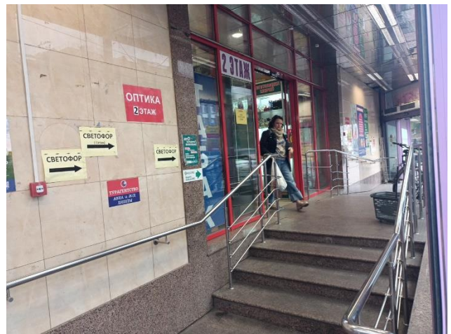
Фото 8. Вход в здание
