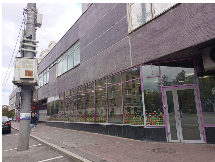
Фото 2. Внешний вид здания
