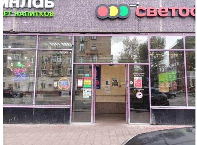
Фото 4. Внешний вид здания
