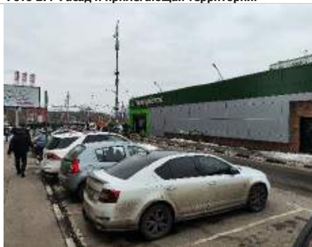
Фото 29. Фасад и прилегающая территория.
