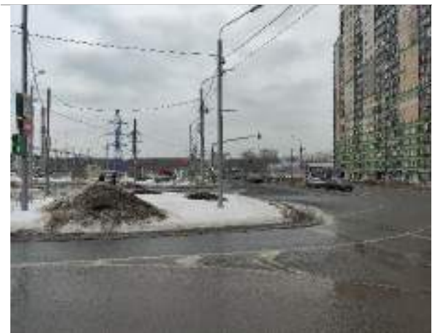
Фото 43. Фасад и прилегающая территория.
