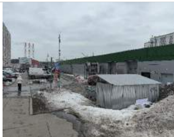
Фото 26. Фасад и прилегающая территория.
