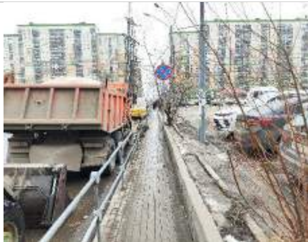
Фото 38. Фасад и прилегающая территория.
