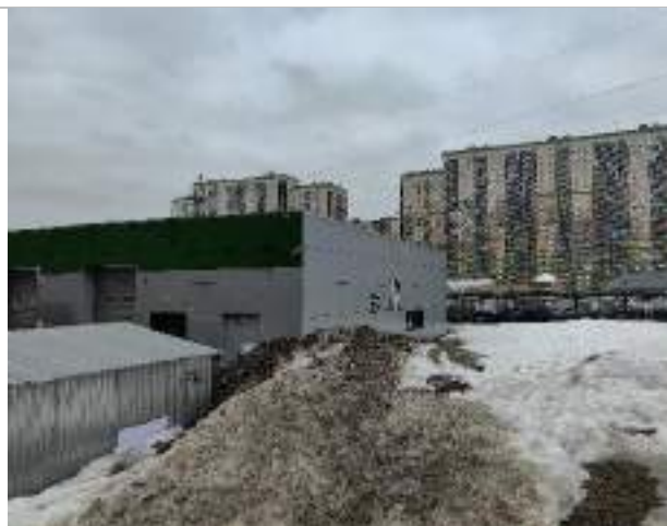
Фото 25. Фасад и прилегающая территория.
