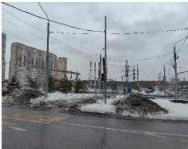
Фото 44. Фасад и прилегающая территория.
