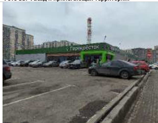
Фото 35. Фасад и прилегающая территория.
