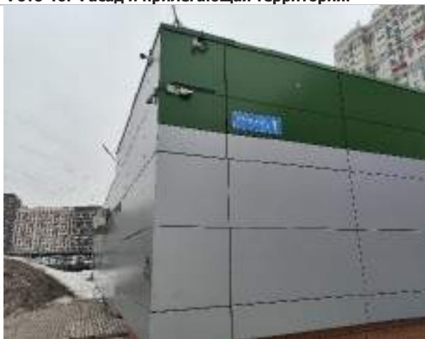
Фото 48. Фасад и прилегающая территория.
