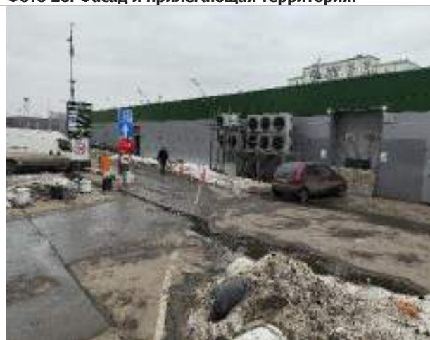
Фото 28. Фасад и прилегающая территория.
