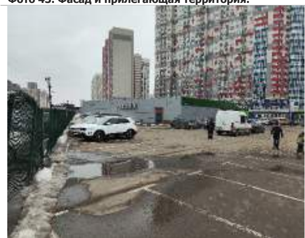
Фото 45. Фасад и прилегающая территория.
