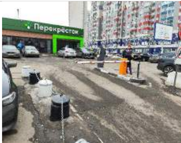
Фото 37. Фасад и прилегающая территория.
