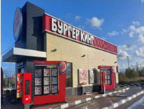
Общий вид здания
