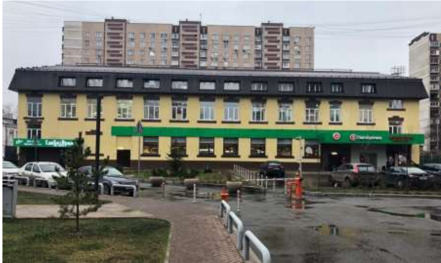
Фото 1. Внешний вид здания
