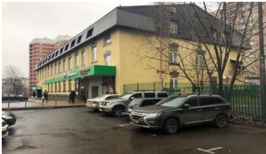
Фото 2. Внешний вид здания
