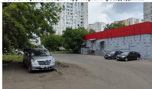
Фото 5. Прилегающая территория и фасад здания.
