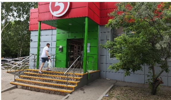
Фотография 3.3. Прилегающая территория, фасад здания
