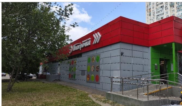
Фотография 3.4. Прилегающая территория, фасад здания
