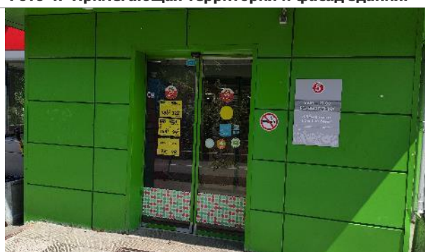
Фото 6. Прилегающая территория и фасад здания.
