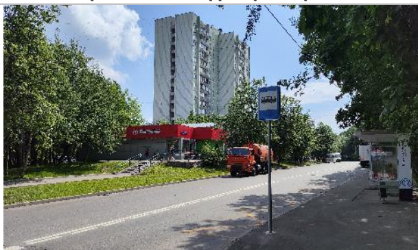
Фото 16. Прилегающая территория и фасад здания.
