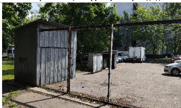
Фото 20. Прилегающая территория и фасад здания.
