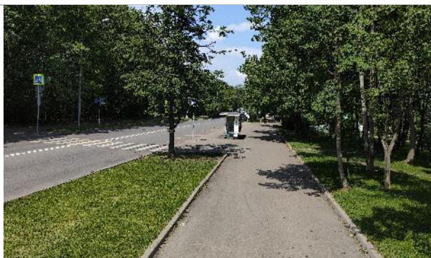
Фото 10. Прилегающая территория и фасад здания.
