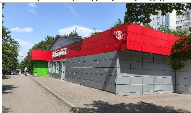
Фото 4. Прилегающая территория и фасад здания.
