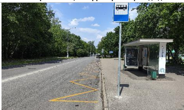
Фото 12. Прилегающая территория и фасад здания.
