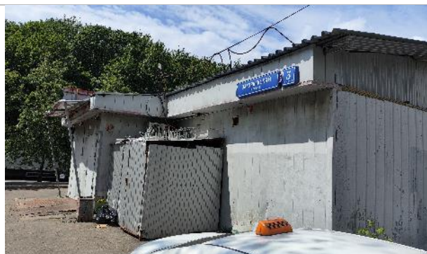
Фото 2. Прилегающая территория и фасад здания.
