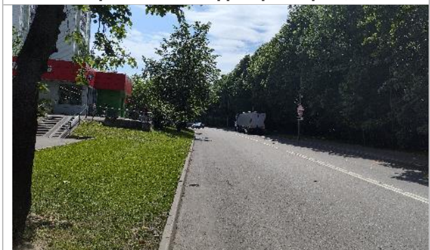
Фото 13. Прилегающая территория и фасад здания.
