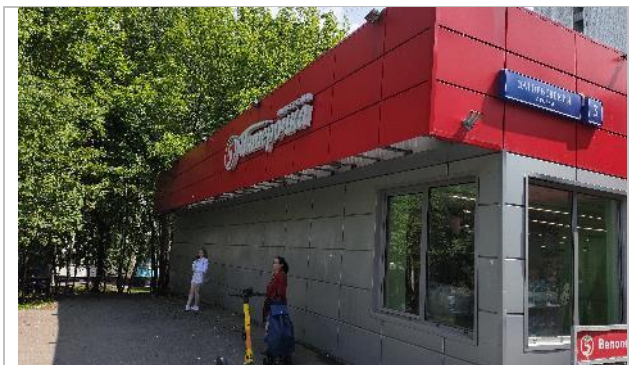
Фото 9. Прилегающая территория и фасад здания.
