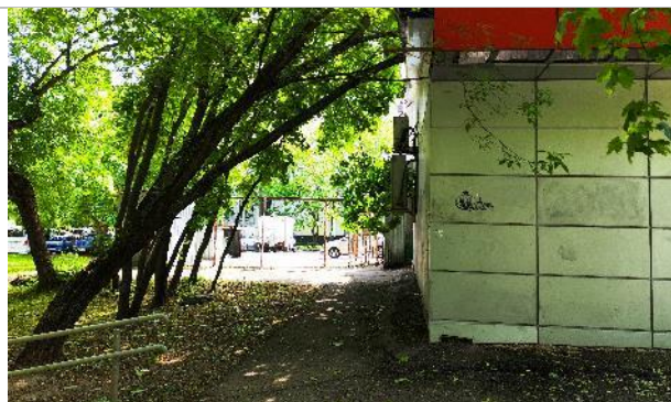
Фото 18. Прилегающая территория и фасад здания.
