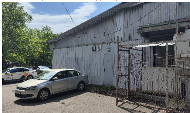
Фото 22. Прилегающая территория и фасад здания.
