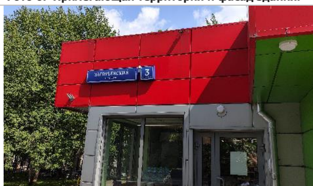
Фото 8. Прилегающая территория и фасад здания.
