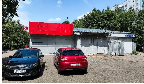
Фотография 3.4. Прилегающая территория, фасад здания
