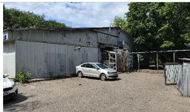
Фото 1. Прилегающая территория и фасад здания.
