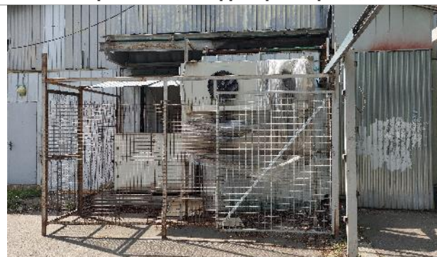
Фото 21. Прилегающая территория и фасад здания.
