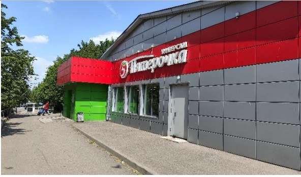
Фотография 3.3. Прилегающая территория, фасад здания
