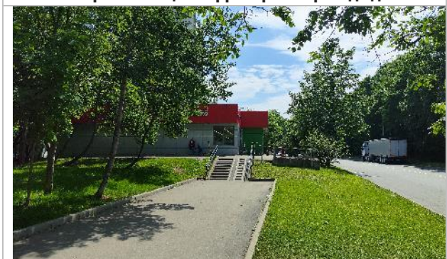
Фото 11. Прилегающая территория и фасад здания.
