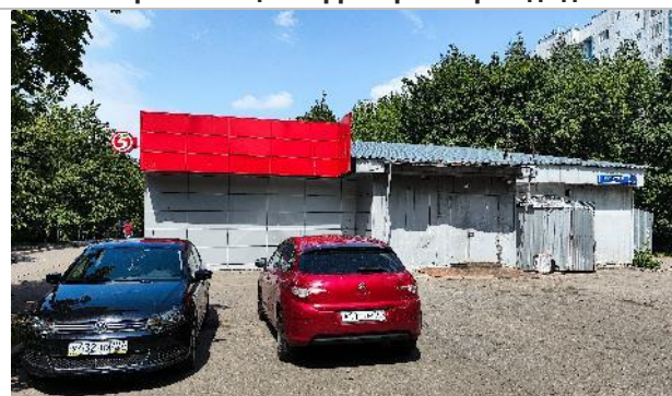
Фото 3. Прилегающая территория и фасад здания.
