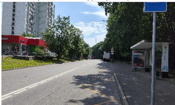
Фото 14. Прилегающая территория и фасад здания.
