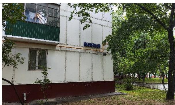
Фото 6. Прилегающая территория и фасад здания.
