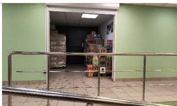
Фото 37. Состояние внутренних помещений.
