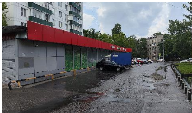
Фото 15. Прилегающая территория и фасад здания.
