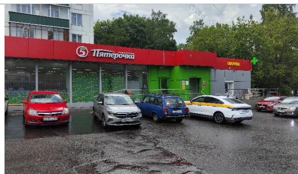
Фотография 3.4. Прилегающая территория, фасад здания
