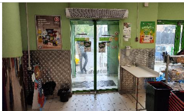
Фото 40. Состояние внутренних помещений.
