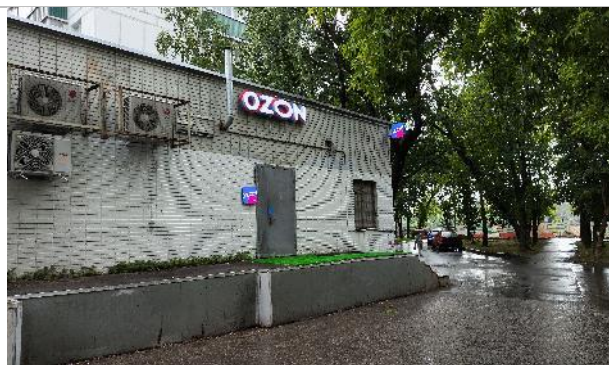
Фото 2. Прилегающая территория и фасад здания.
