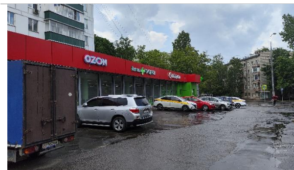
Фотография 3.3. Прилегающая территория, фасад здания
