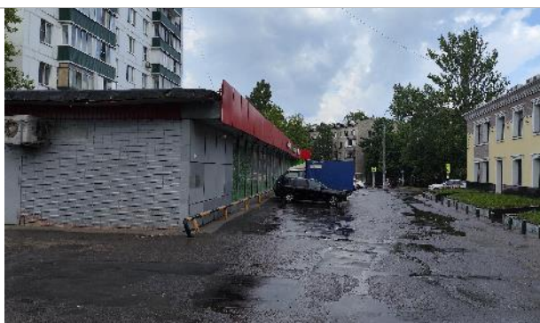
Фото 14. Прилегающая территория и фасад здания.
